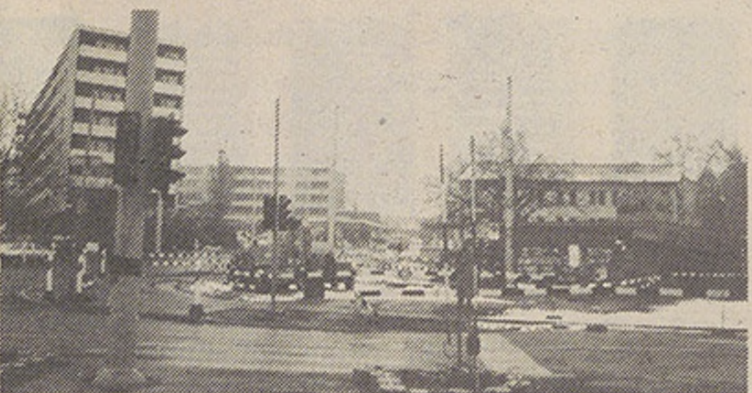
Baustelle im Frankental
