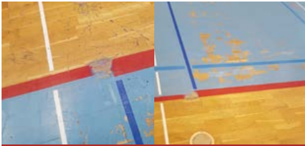
Hallenboden vor der Sanierung
