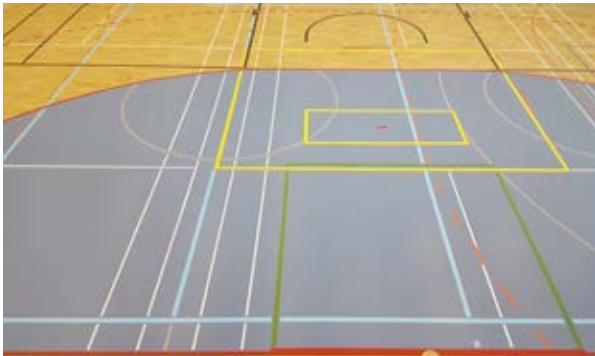
Hallenboden nach der Sanierung
