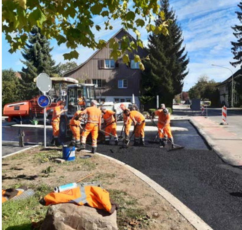
Die Eichholzstrasse wird umfassend saniert
