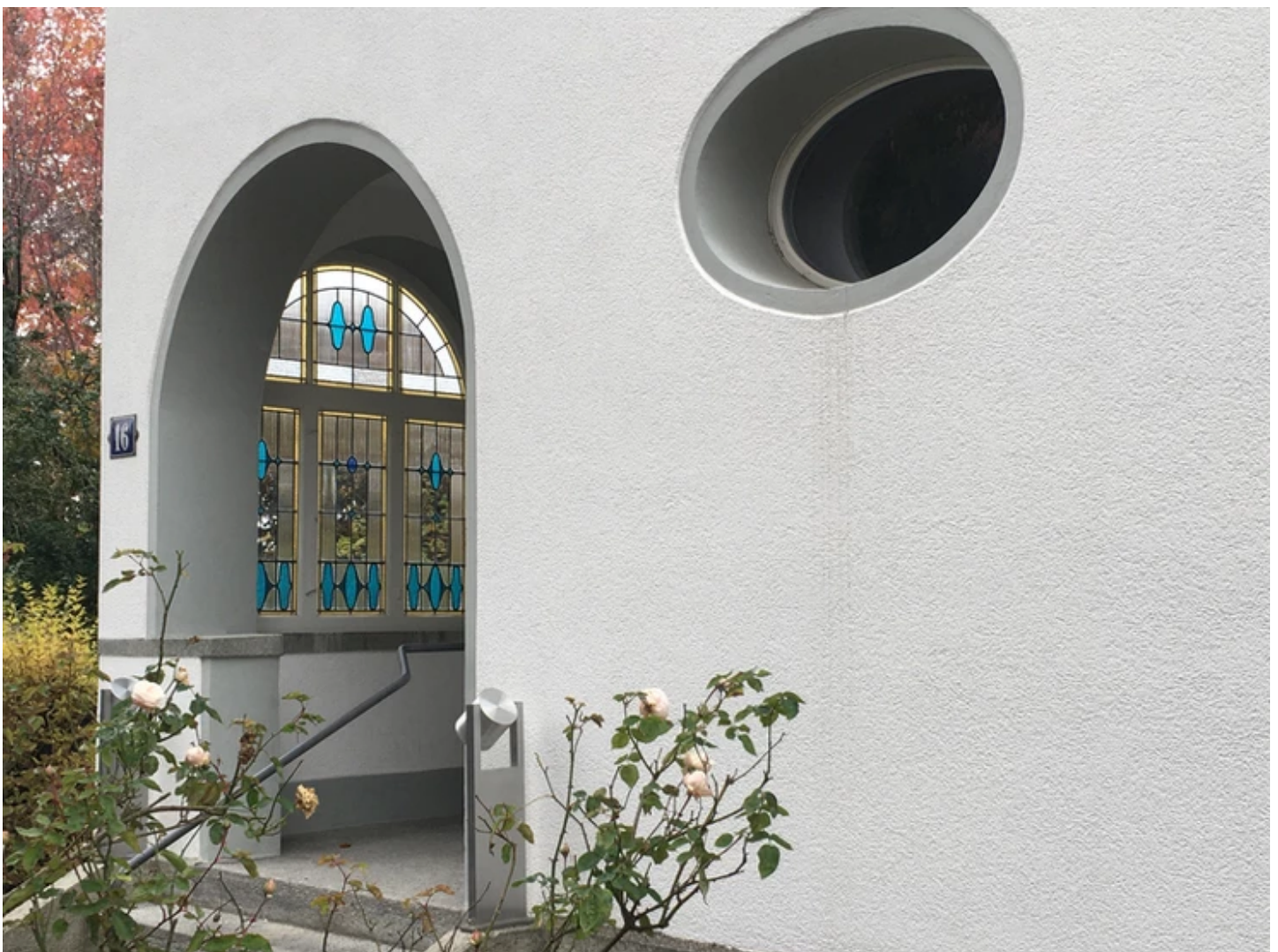
Drosselstrasse 16, Jugendstil-Eingangsbereich. Foto: SB (19.11.2021).
