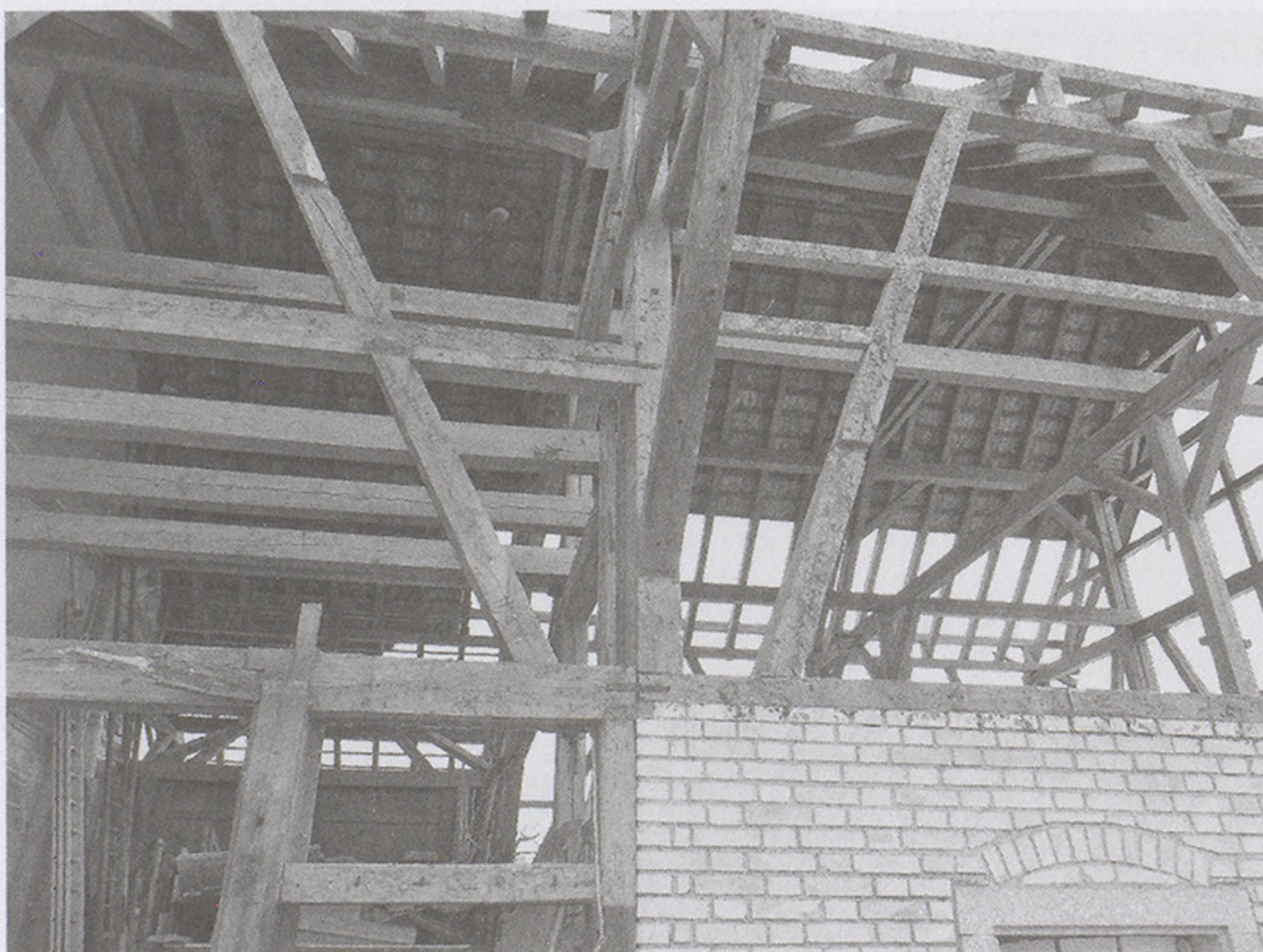
Der Dachstock des alten Stalls: Balken, wohin das Auge reicht.
