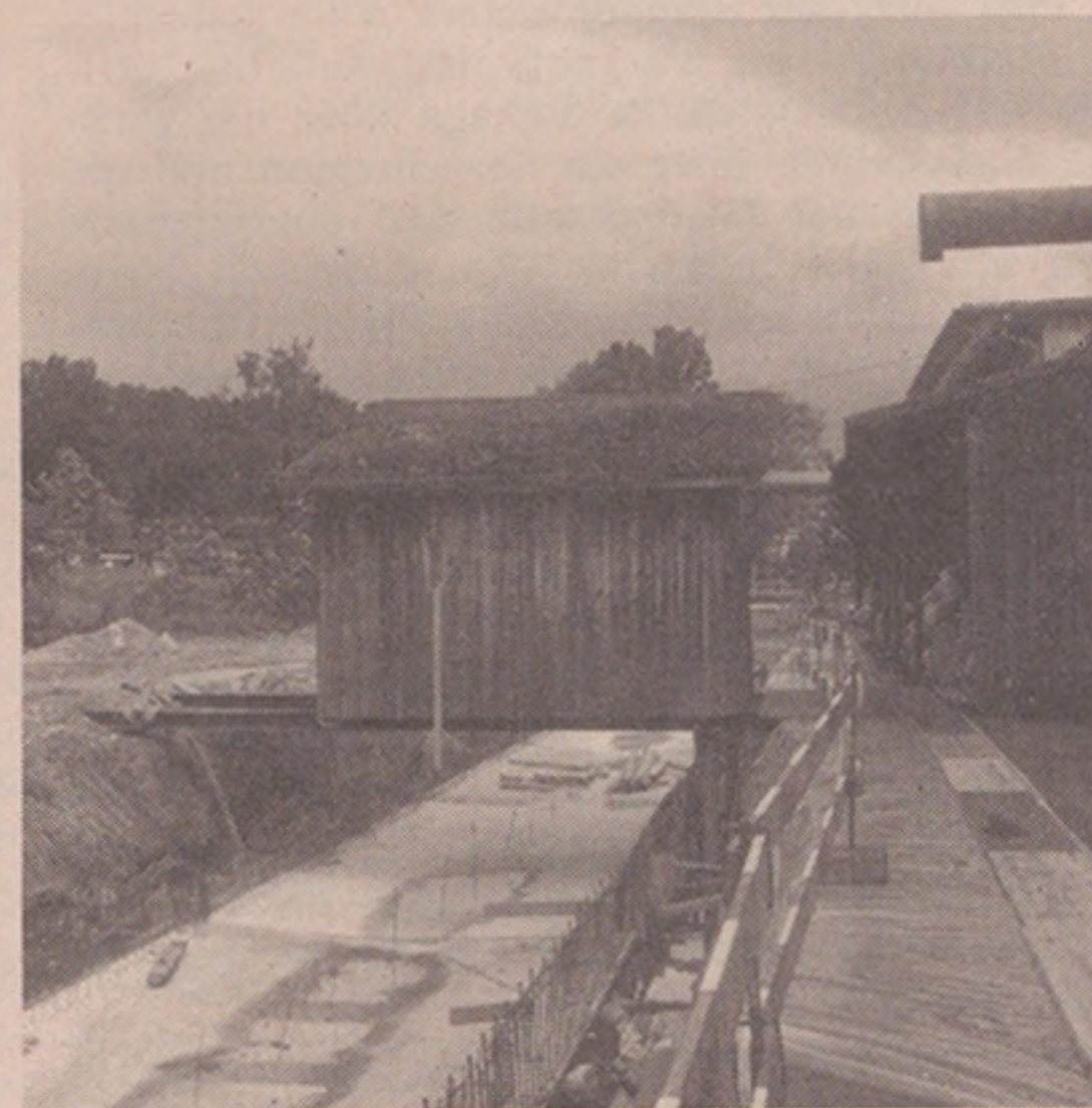
Das «erhobene» Staubhüsl der Bettfedernfabrik Müller-Imhoof, über dem im Bau befindlichen neuen Hauser-Kanal.
