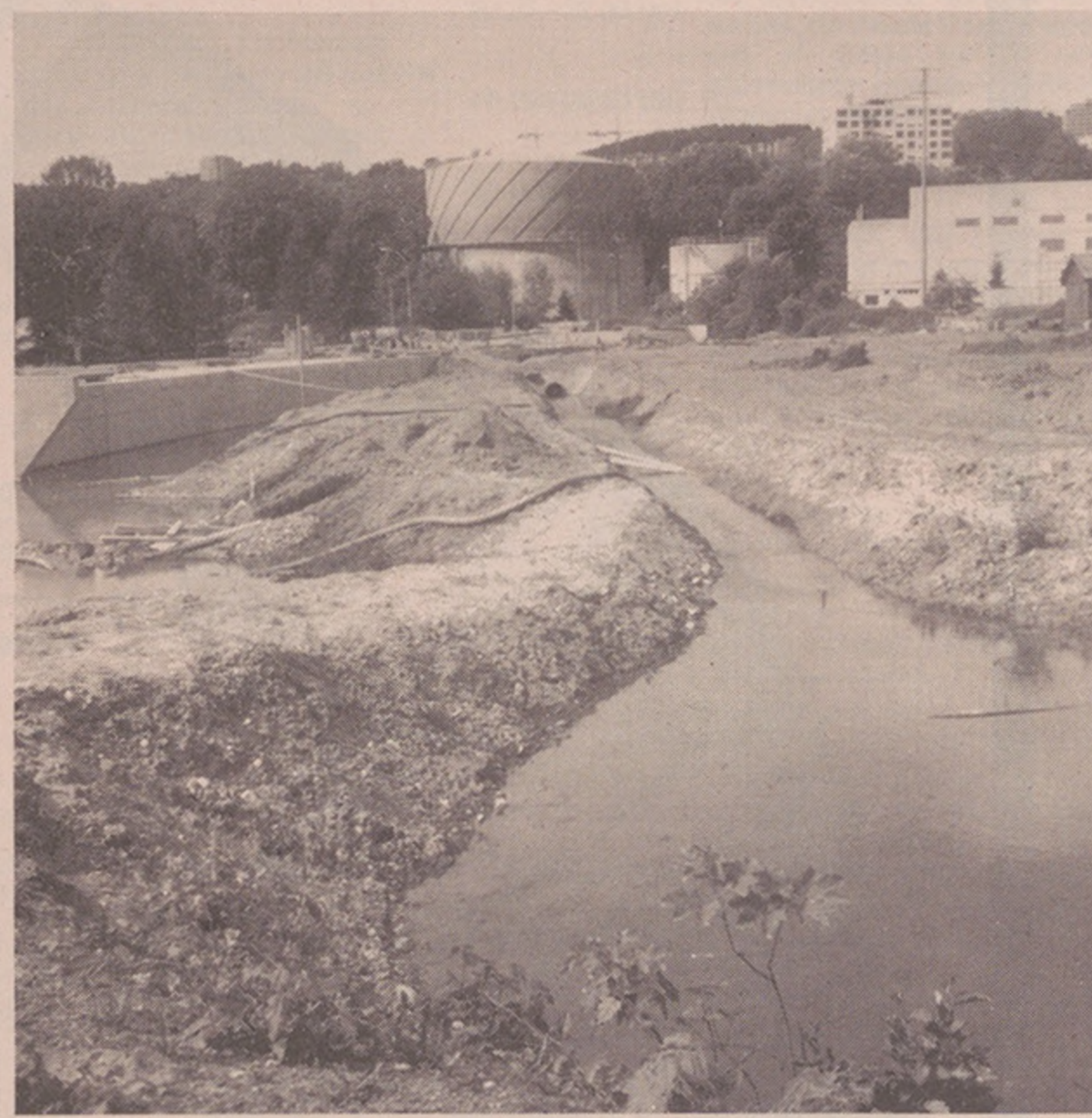
Provisorischer Lauf des Hauser-Kanals (im Hintergrund das Baugelände mit einem Teilstück des neuen Kanalbeckens, links im Bild).
