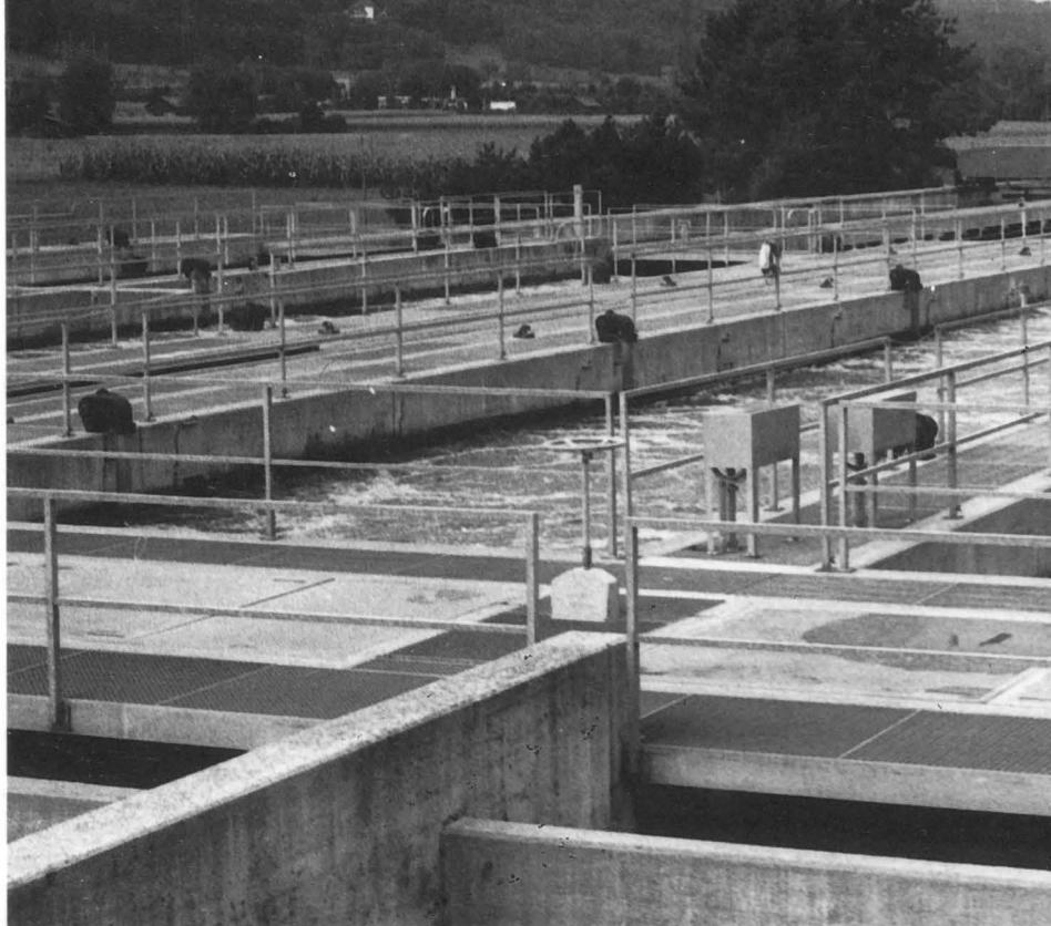
Kläranlage Fällanden: Überblick über die Klärbecken.
