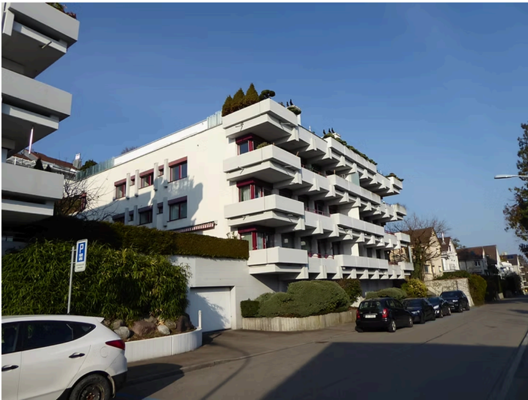
Beton macht's möglich. Balkone mit Seesicht. Kilchbergstrasse 122-124.
