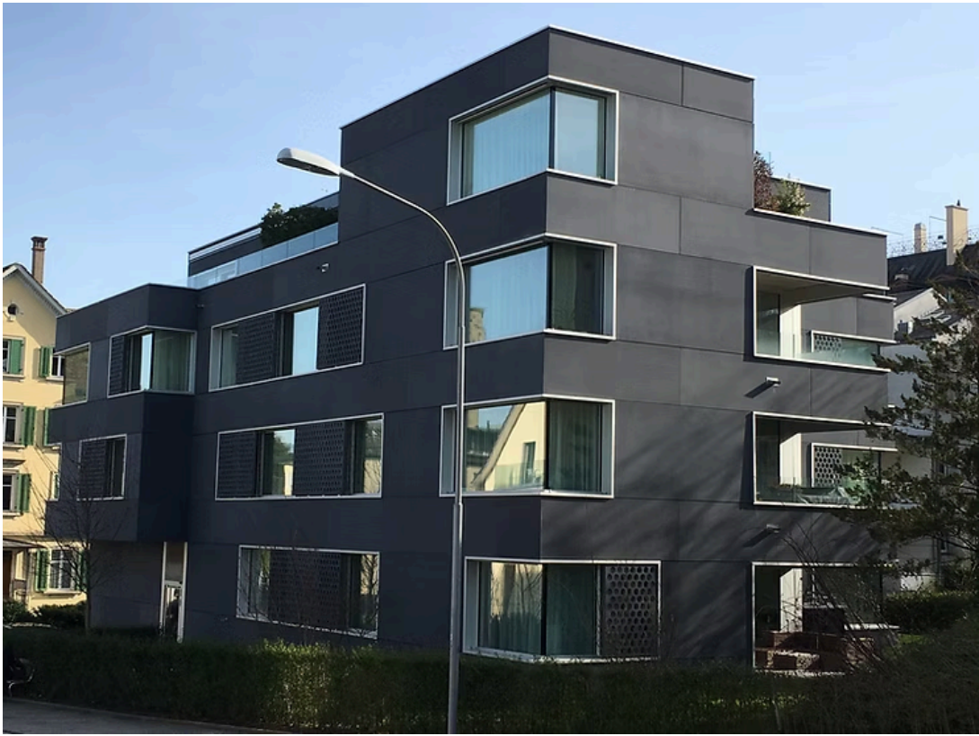
Dachterrassen, Erker und Loggias. Neubau Butzenstrasse 3. SB (19.2.2021)
