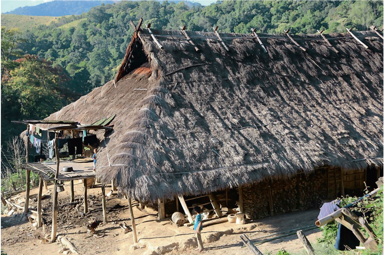
Abb. 77. Myanmar. Lehmbofen in einem zweigeschossigen Haus. Die untere Etage wird als Werk- und Lagerplatz benutzt, die obere Etage ist die Wohnetage. Unter der Dachterrasse befindet sich eine Abfallzone. Langhaus eines Bergvolkes im östlichen Myanmar.
