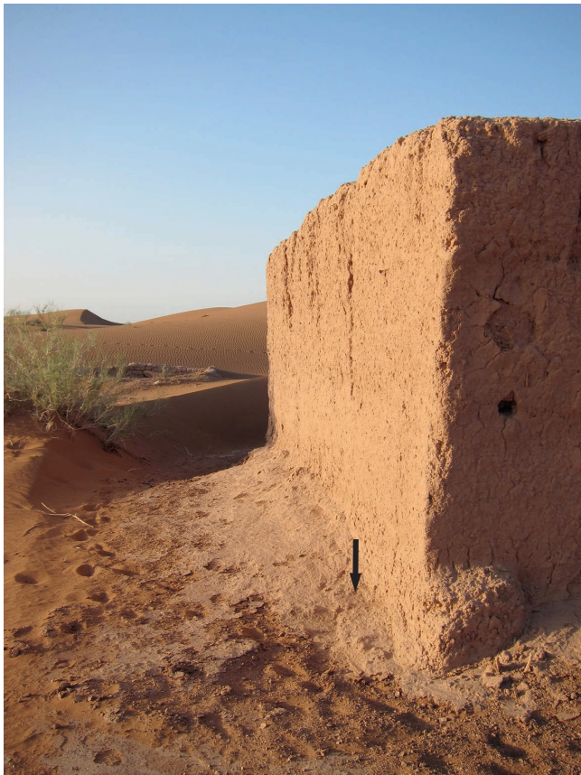
Abb. 88. Marokko, 2013. Aufgelassenes Lehmziegelgebäude. Die herabgefallenen Fragmente des Verputzes zeichnen sich entlang der Aussenwände als helle lehmige Lagen im dunkleren Sand ab. An der Oberkante der Lehmziegel sind bereits durch den Regen ausgewaschene Rinnen sichtbar.
