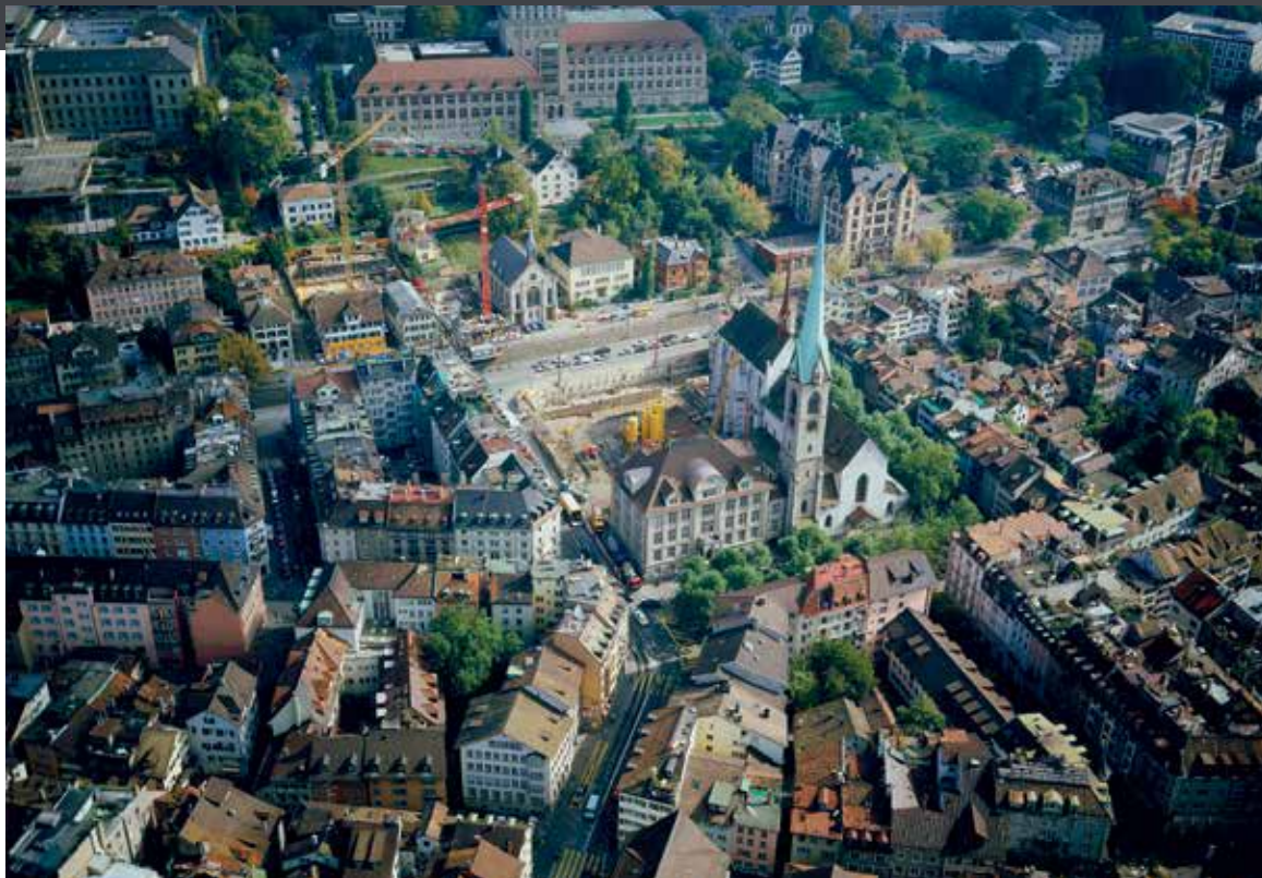
Luftaufnahme der Baustelle, 1990.
