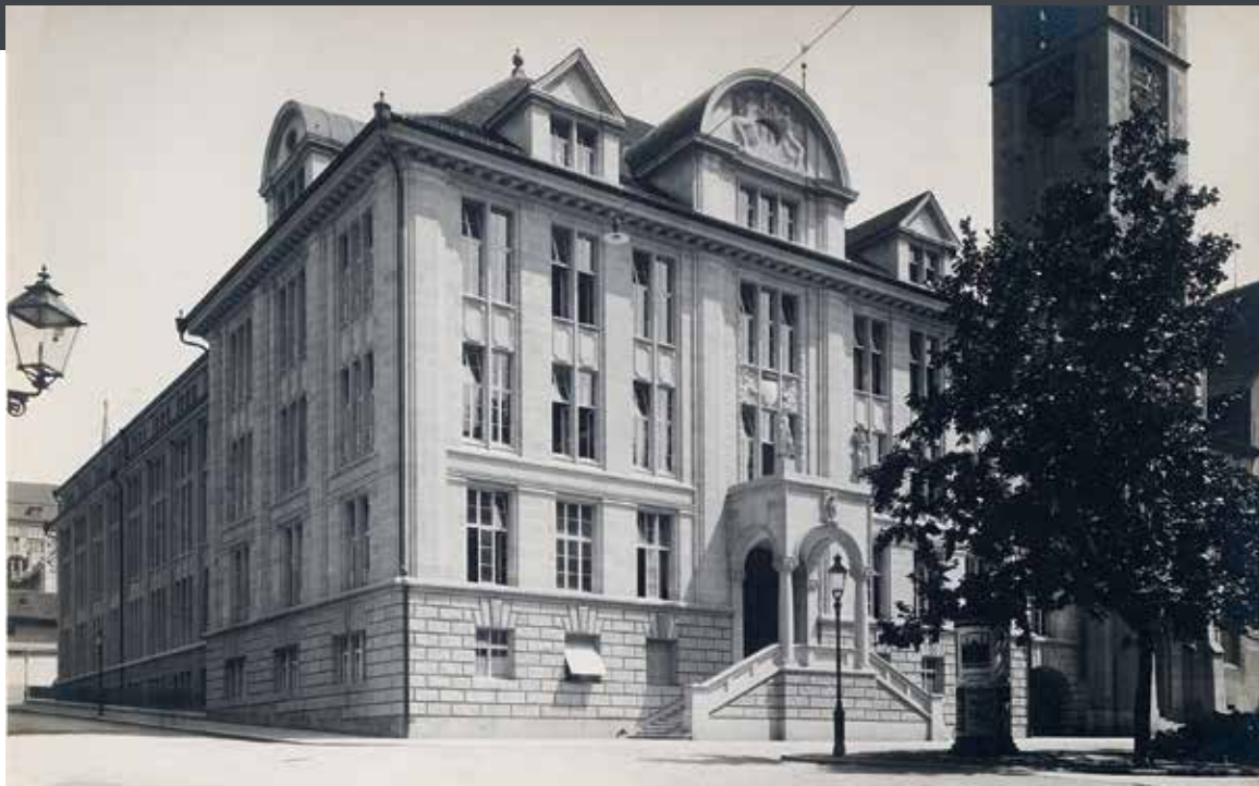
«Ein Stahlbetonbau in zeitgemässer Konstruktion, seine Ästhetik sachlich bestimmt», wird der Bibliotheksneubau von 1917 in der Fachliteratur beurteilt.
