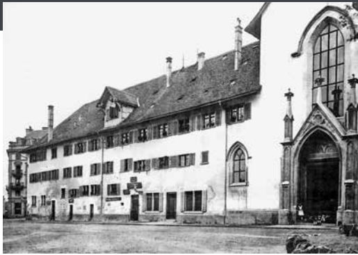
Das Spitalamtshaus, fotografiert um 1880.
