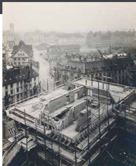
Blick über die Baustelle in Richtung Urania.
