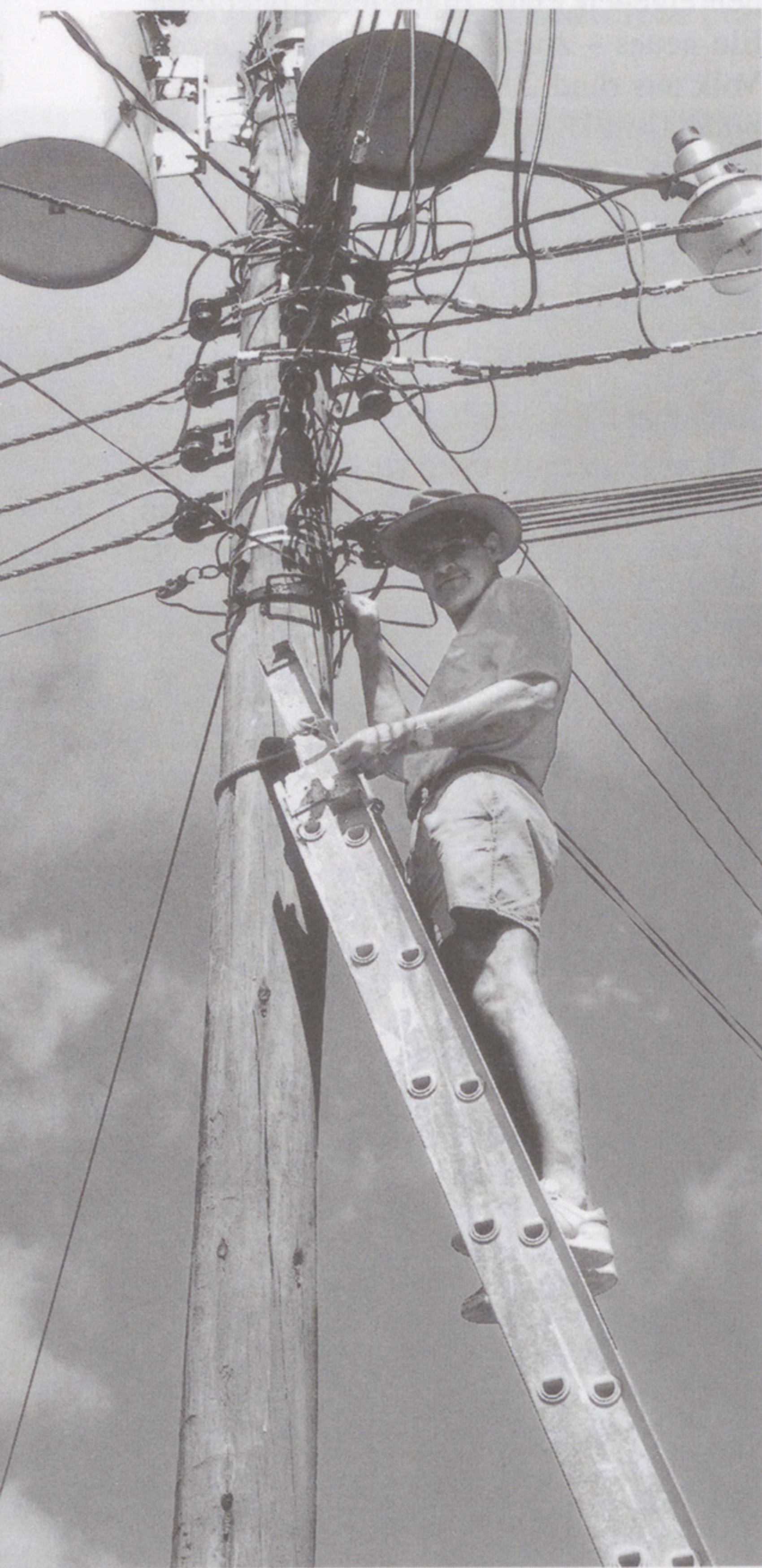
Eugen beim Kabel montieren. Ob da das Telefon am richtigen Ort klingen wird? (Foto: zvg)
