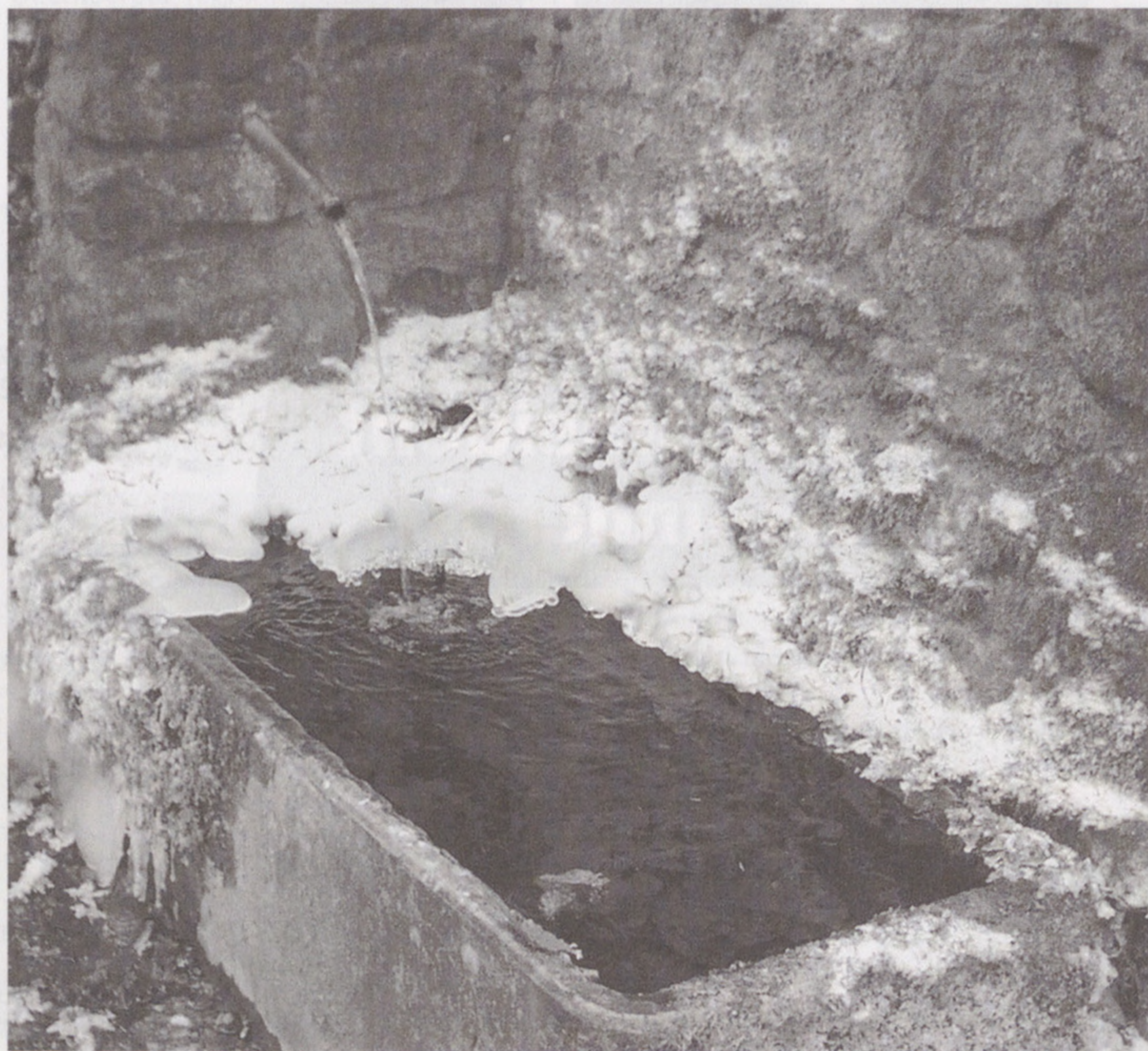
Der Brunnen bei der Waldhütte der Holzkorporation Aesch.
