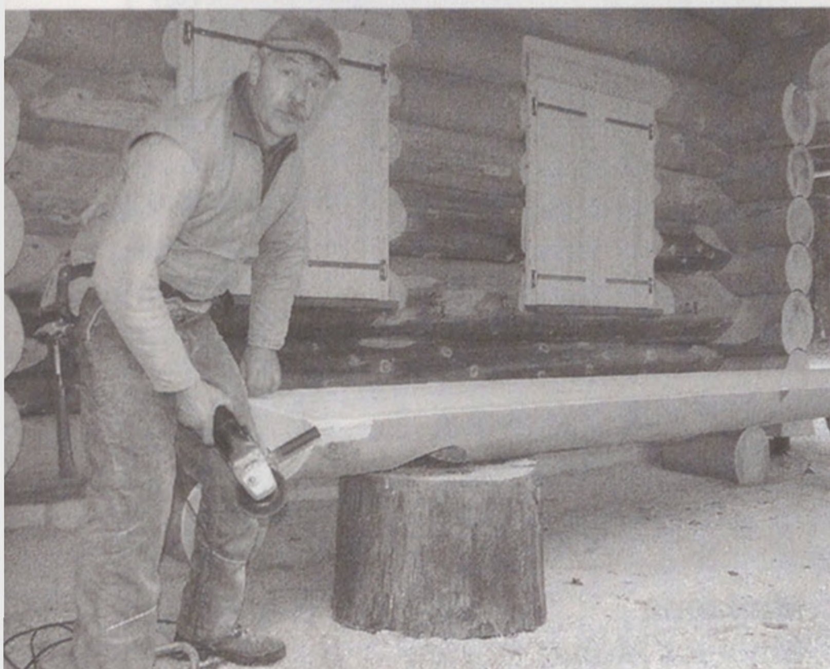
Zwei Bänke dienen nun vor dem Blockhaus als Sitzgelegenheit. Vorher war viel Arbeit dazu nötig. (Fotos: sl)
