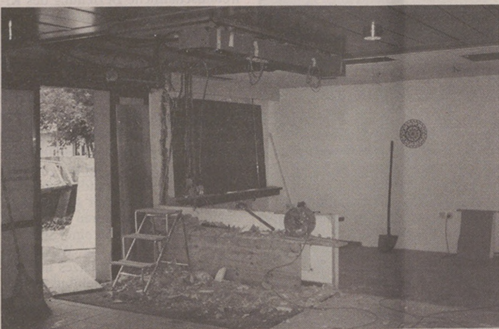
Baustelle in der Hauserstiftung an der Hohenklingenstrasse 40. Zurzeit gähnende Löcher. Alle, Pensionäre und Besucher freuen sich auf die neue Cafeteria.
