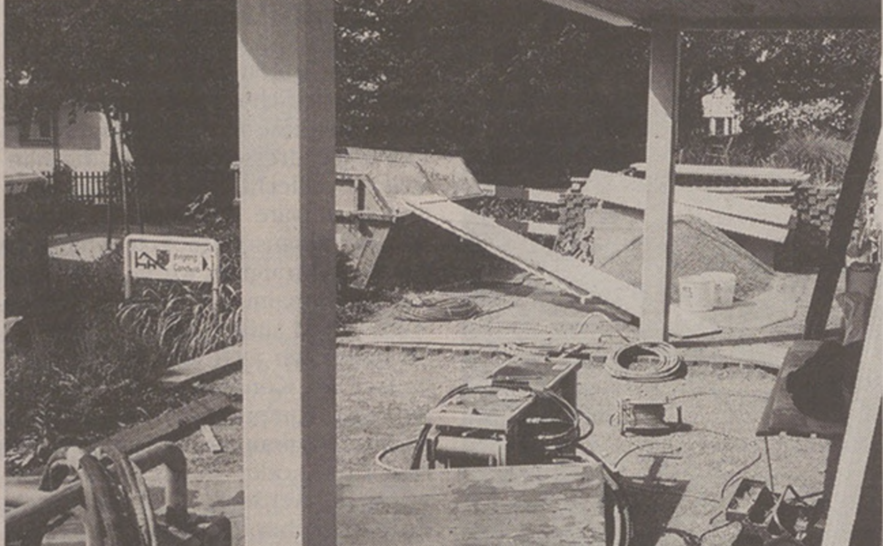
Bauen ist nun mal mit Umtrieben verbunden. Den Ablauf und den Fortschritt zu beobachten kann man als willkommene Abwechslung betrachten, somit gelassener verkraften.
