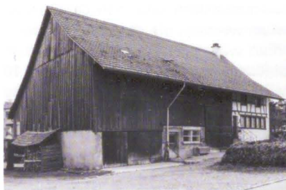
Der Pfarrain 3 als Bauernbetrieb (Bild: Bauamt Volketswil)
