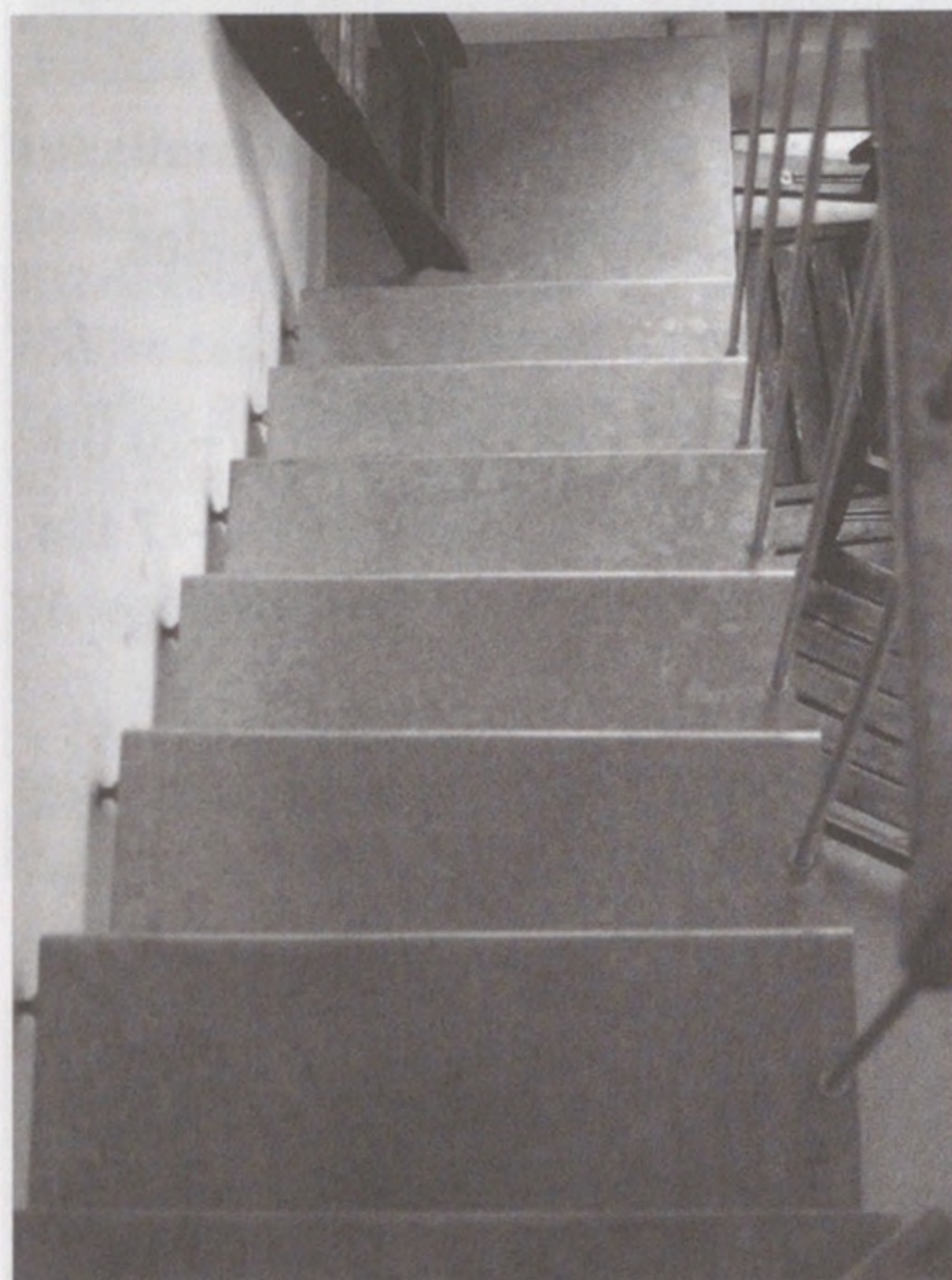
Die Metalltreppe, die alle drei Geschosse erschliesst.
