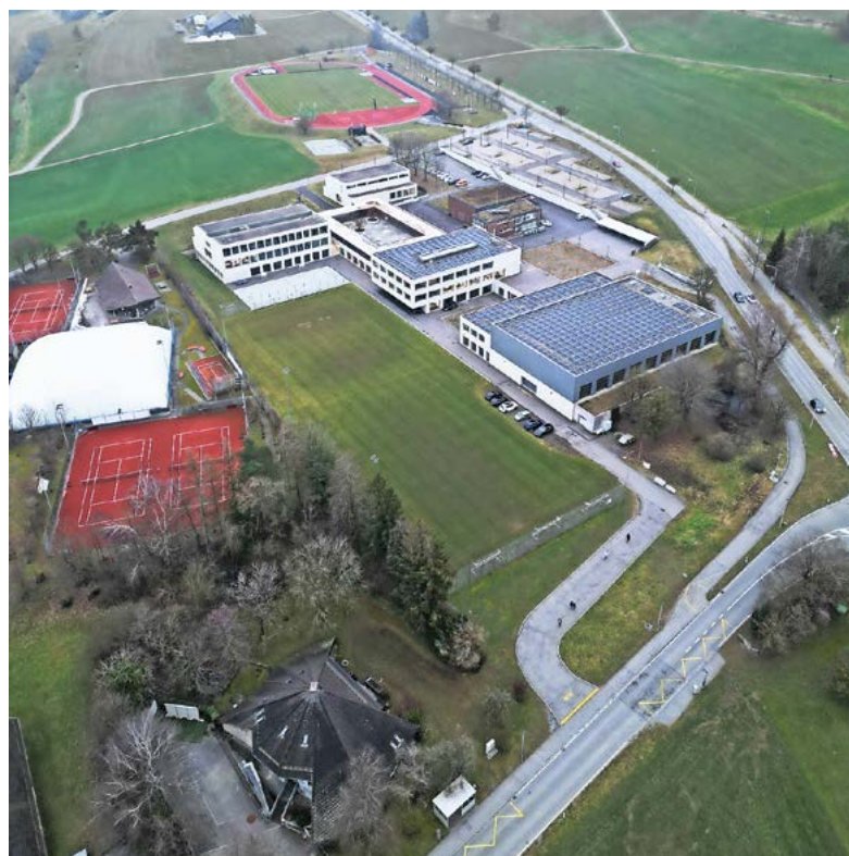
Ein Projektwettbewerb soll den Masterplan Sport und Freizeit für die Loorenanlage konkretisieren (Luftbild: DHPA AG).
