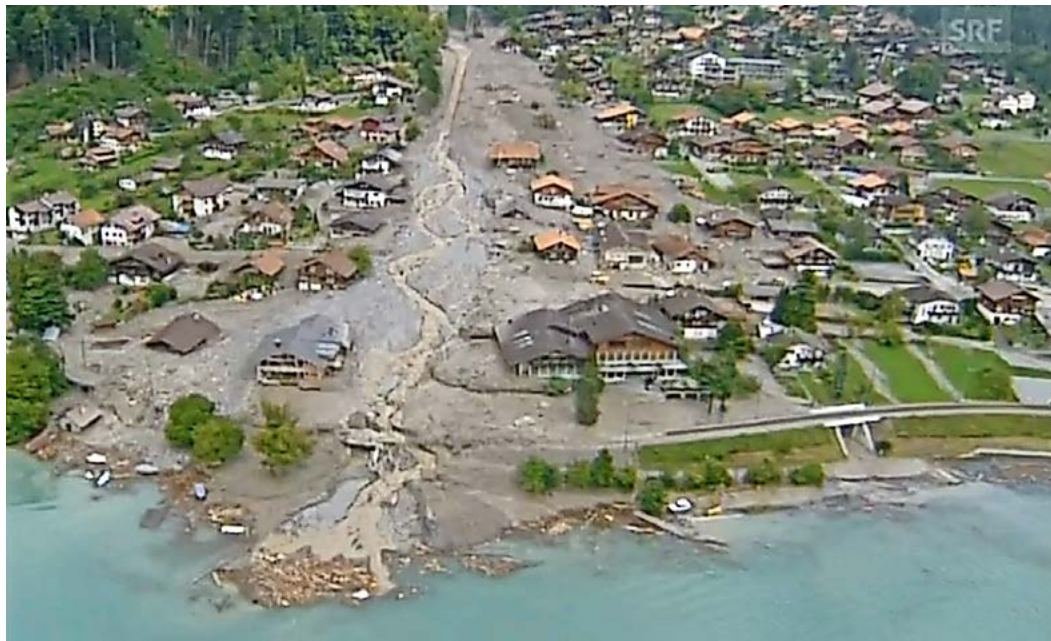
Die Glyssibachröfe in Brienz nach dem Hochwasser.
