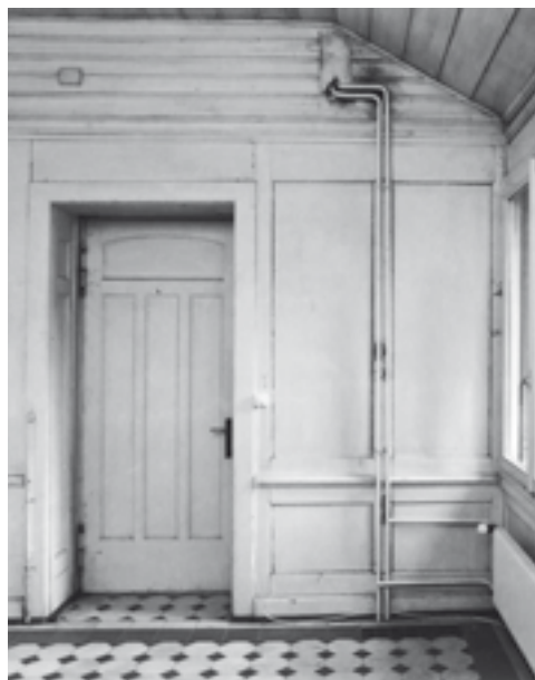
Nebentreppenhaus bzw. Korridor (ohne Raum Nr.). Links: Türe zum Schreibsalon (Raum Nr. 1.07); Jugendstilfries am Deckenansatz. Rechts: Balkonraum, ehem. Veranda (Raum Nr. 1.09). Zustand Dezember 2004. Fotos Urs Kaiser, Malters/LU.
