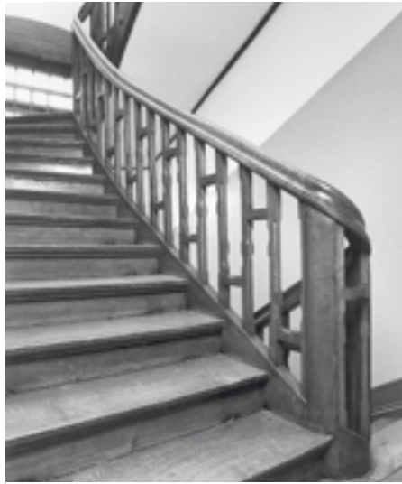
Nebentreppenhaus bzw. Korridor (ohne Raum Nr.). Links: Nische mit eingebautem Waschbecken und Rollladen. Rechts: Teilansicht der Brüstung im Nebentreppenhaus. Zustand Dezember 2004. Fotos Urs Kaiser, Malters/LU.
