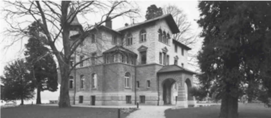
Gesamtansicht von Westen mit der 2004 neugestalteten Umgebung. Zustand April 2005. Foto Urs Kaiser, Malters/LU.
