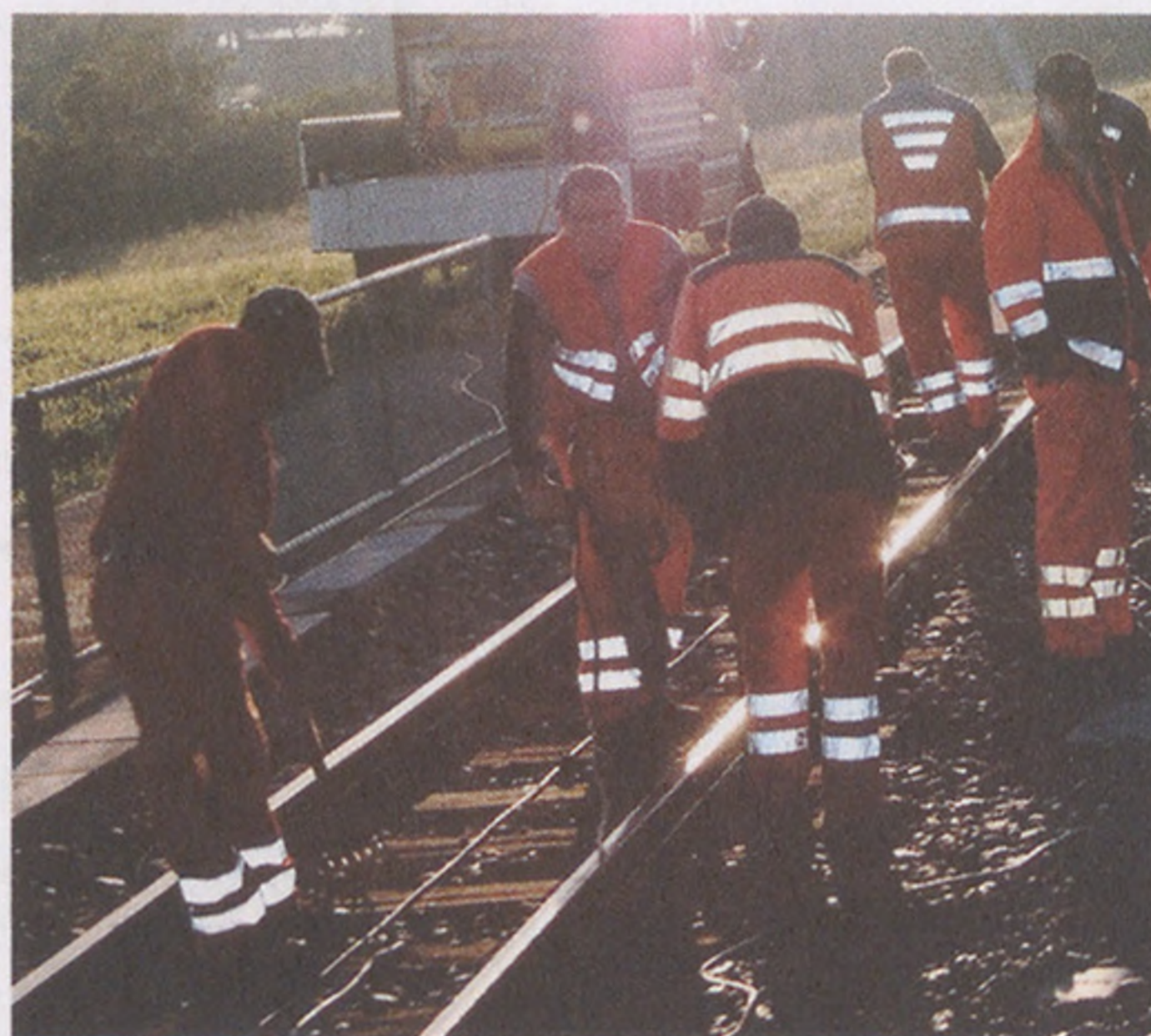
Vorsicht ist angesagt: Gleisarbeiter bei Neuhaus an der Arbeit, zwischen Hinteregg und Forch.
