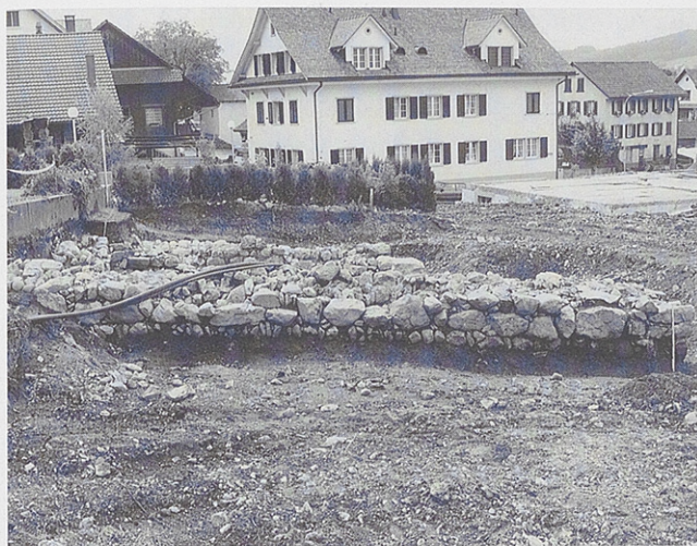
Abb. 14. Ansicht der östlichen Ringmauer, in Richtung Westen. Auffällig sind die kleinen schräg gestellten Steine in der untersten Fundamentlage. Darüber waren noch ein bis zwei Fundamentlagen erhalten, deren Mauerschalen aus deutlich grösserem Steinmaterial bestanden.
