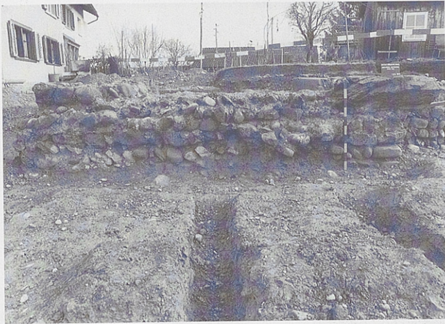
Abb. 13. Blick von Süden auf die Kapellenmauer (M 1). Fundament: fünf Steinlagen gegen die Erde gesetzt (die untersten beiden Steinlagen ohne Mörtel). Rechts eine mächtige Bruchsteinplatte als Eckverstärkung der Chorschulter. Links und rechts eine Steinlage aufgehendes Mauerwerk.
