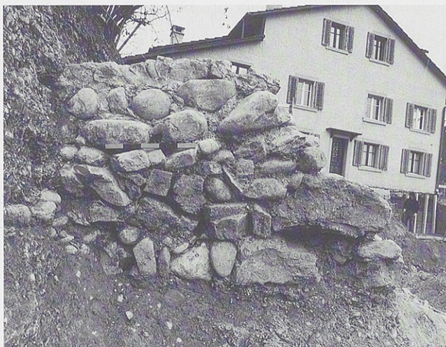
Abb. 4. Blick von Süden auf das Fundament und eine Steinlage des aufgehenden Mauerwerks des Wohnturms (Aussenseite). Rechts eine Eckverstärkung. Im Hintergrund Gebäude 981.
