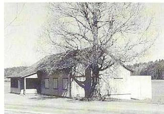
Schiessanlage Obere Wangenstrasse 1910 300m-Scheibenanlage, Schützenhaus Schiessverein Brüttisellen Schiessverein Wangen Politische Gemeinde Wangen-Brüttisellen
