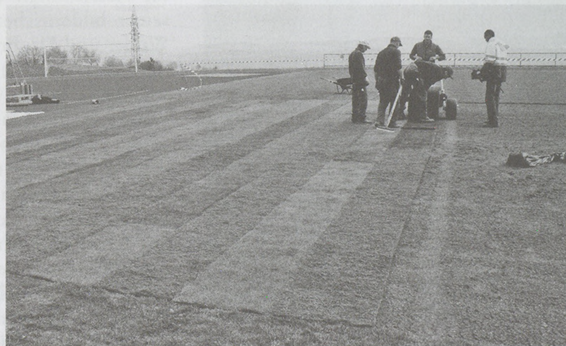
Präzisionsarbeit: Die Arbeiter der Otto Keller Gartenbau AG verlegen die Bahnen des Rasens.
