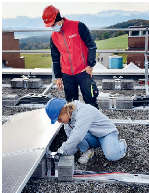
Schüler montierten Solarpanels auf dem Dach des neuen Schulhauses Nord. Bild: Dörte Welti
