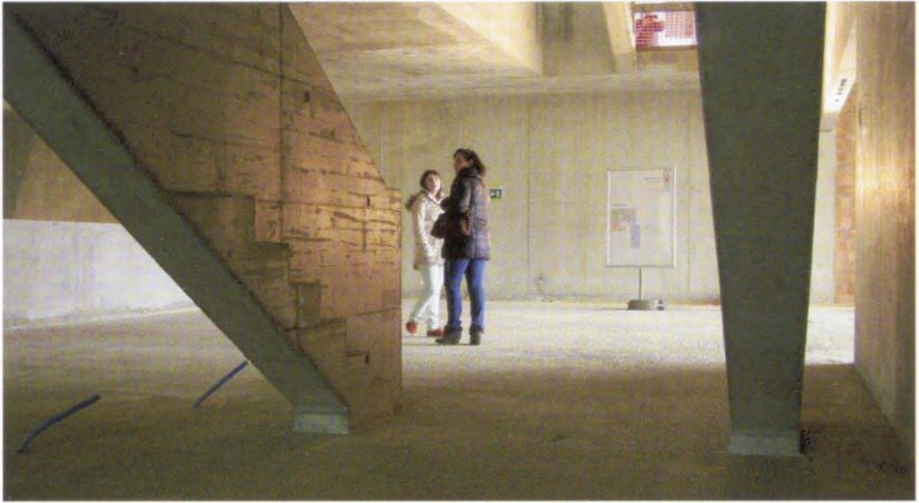
Interessierte bestaunen den Rohbau des neuen Gemeindehauses am Tag der offenen Baustelle. (Bild: Toni Spitale)
