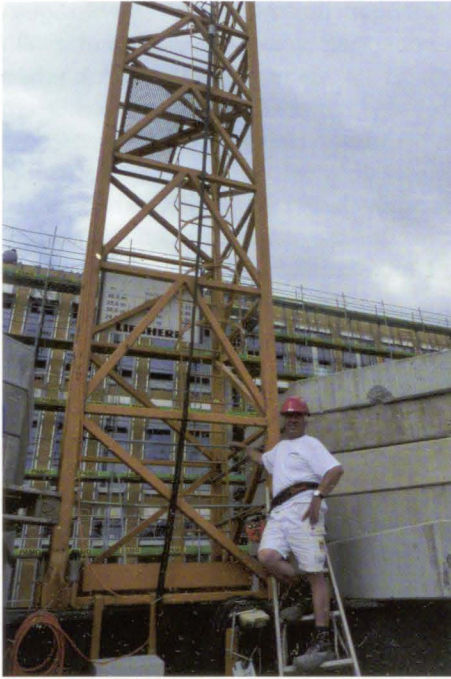
Kranführer Dodic Blagoje steigt auf seinen Turmdrehkran Liebherr 160 EC-B 6.
