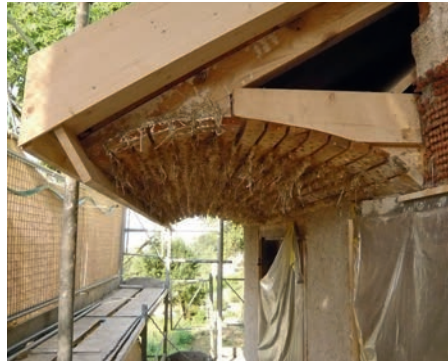
Links: Dachuntersicht auf der Nordseite mit Hohlkehle. Rechts: Dachuntersicht auf der Südseite nach der Entfernung der Verschalung. Gut zu erkennen sind die Dachlatten mit dem getrockneten Gras, welches als Putzträger diente. Zustand 2013. KDP Fotoarchiv.
