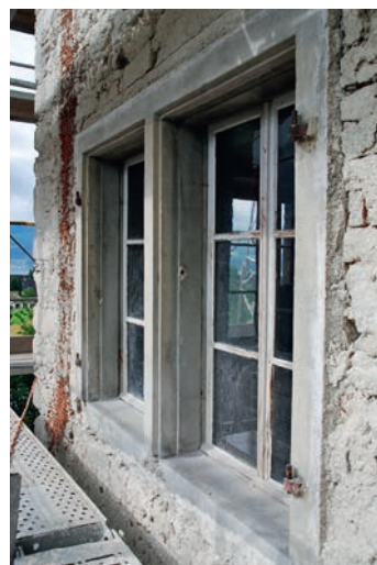
Beim Wohnhaus Wellenberg 5 wurden sowohl Holz- als auch Sandsteingewände verwendet. Zustand 2013. KDP Fotoarchiv.
