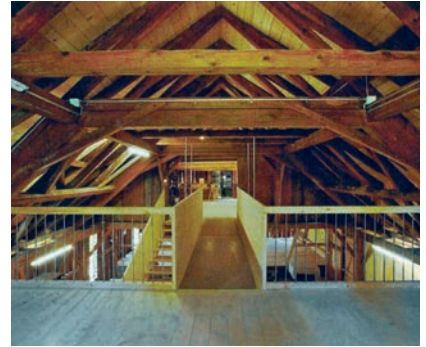
Dachraum der grossen Scheune gegen Süden. Die gegenläufig geführte Holzterrasse erschliesst neu die beiden obersten, brückenartig verbundenen Niveaus über der südlichen Trotte und der nördlichen Remise. Juni 2014. KDP Fotoarchiv.
