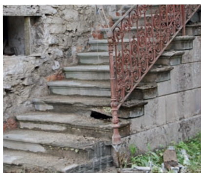
Östlicher Treppenlauf: Neue Stufen (oben) und Gesamtansicht vor der Restaurierung (unten), Putz und Zementsockel sind bereits entfernt. Beide Fotos Juni/Juli 2013. KDP Fotoarchiv.
