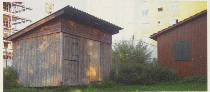
Die Mojawi-Baracke nach Renovation
