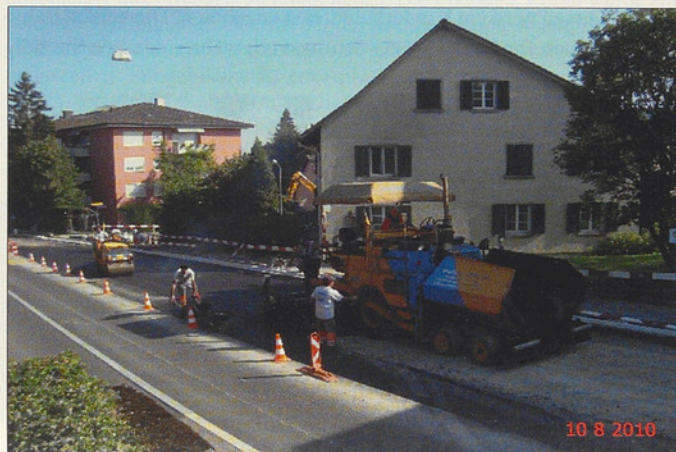
Belagseinbau ist eine heisse Angelegenheit
