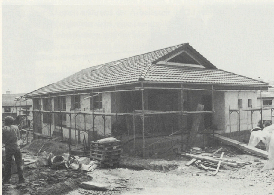
Neubau Kindergarten Lindau
