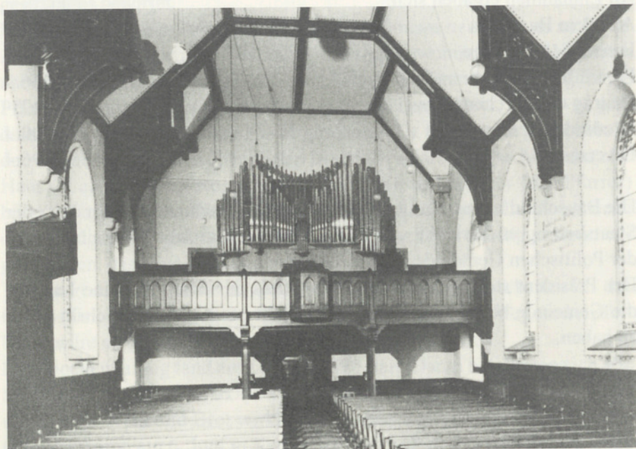
Inneres der Kirche vor der Renovation 1967/68.
