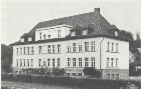
Schulhaus Schlimperg, Effretikon
