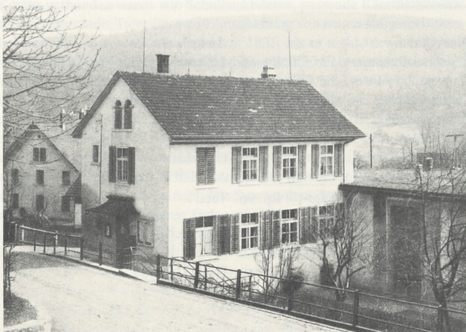
Schulhaus Grafstal 1836/37, Provisorium mit Flachdach 1896
