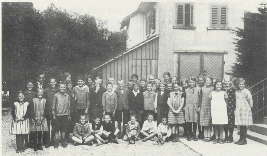
Arbeitsschulhaus mit Feuerwehrlokal Tagelswangen vor dem Umbau (1927)
