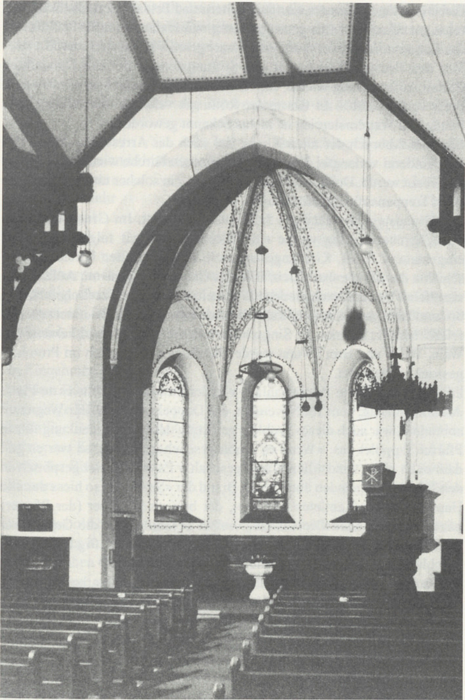
Inneres der Kirche vor der Renovation 1967/68. Blick zur Kanzel und zum Chor.
