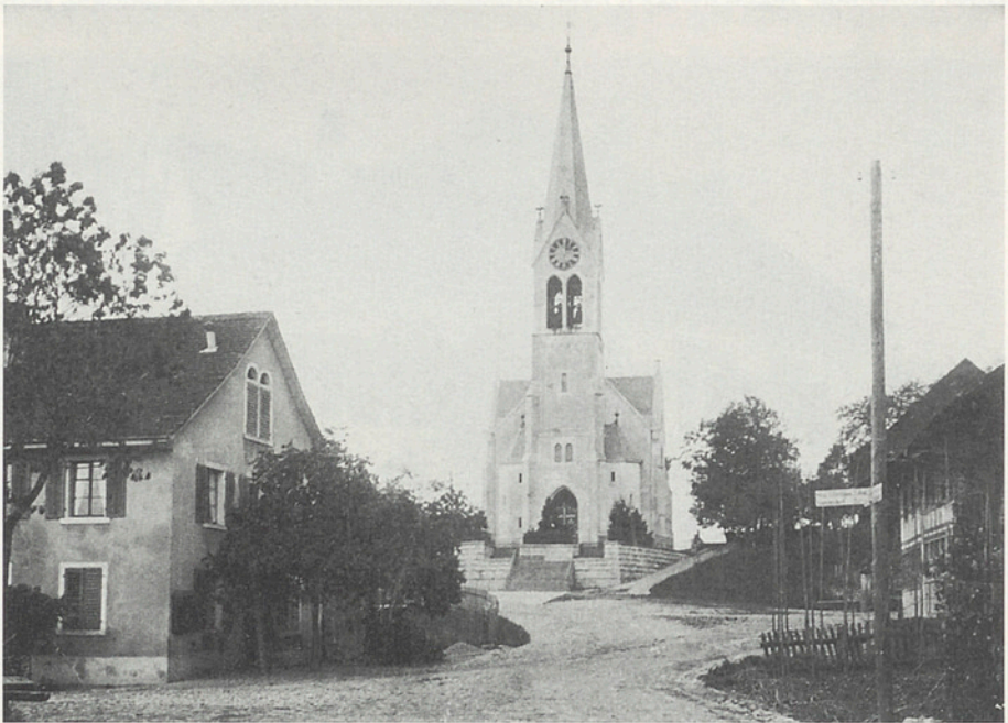
Dorfplatz Lindau: Links das Schul- und spätere Gemeindehaus, rechts Haus «Scharfeck» wurde Bauplatz für Schulhausneubau 1908
