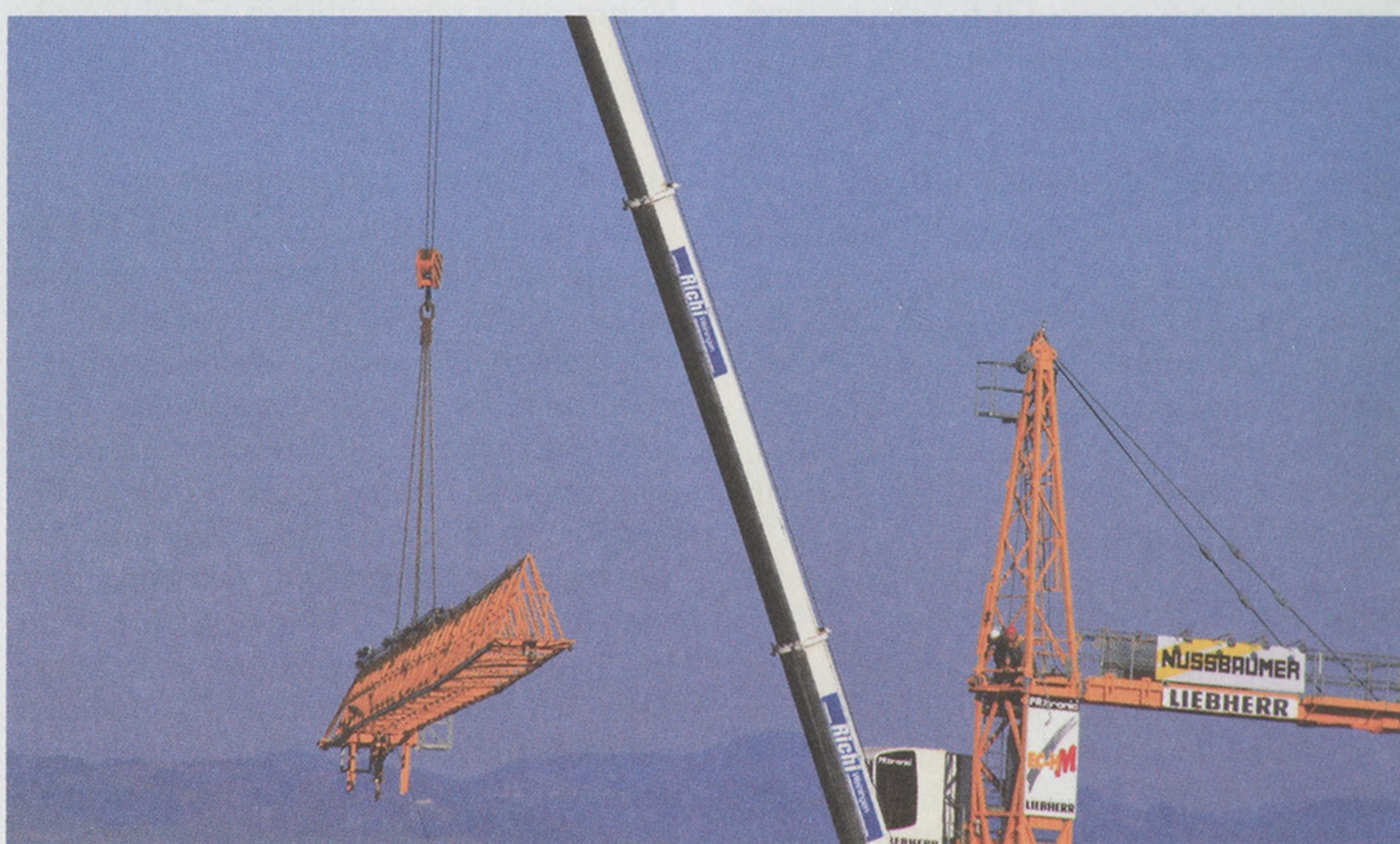
Der Kran hoch über Maur wird Stück für Stück zusammengesetzt. Ein Arbeitsplatz für Schwindelfreie. (Foto: Elsbeth Stucky)
