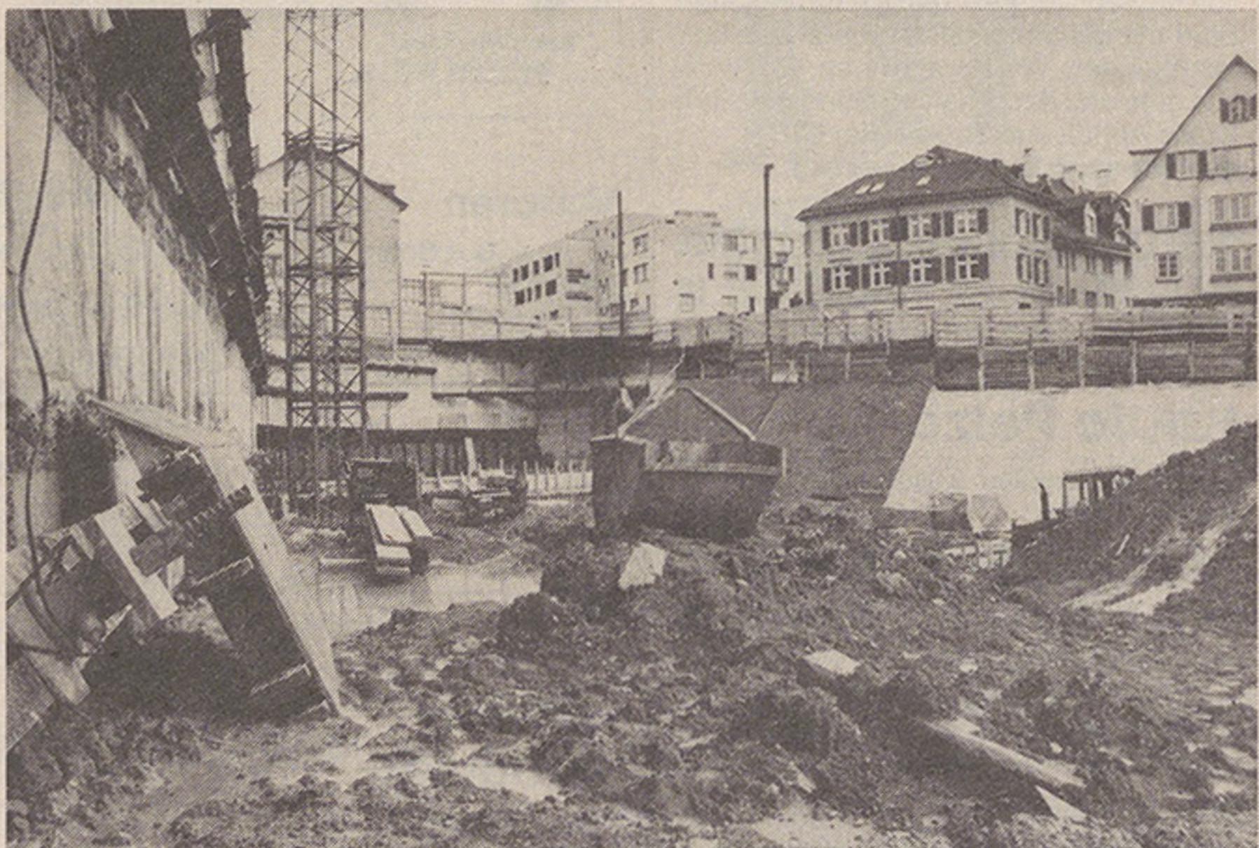
Die trapezförmige Baugrube wies Ausmasse von rund 80×50×9 m aus.
