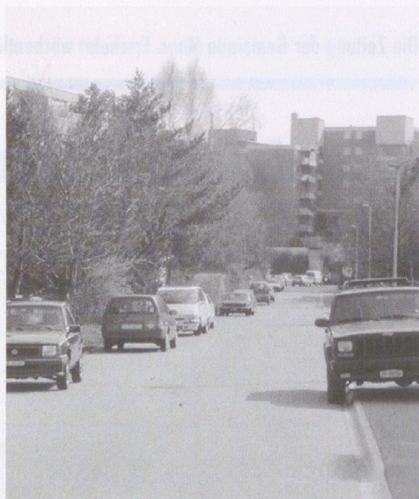
Die Stichstrasse «im Brünneli», Aesch, wird vielleicht bald eine Wohn- und Spielstrasse.
