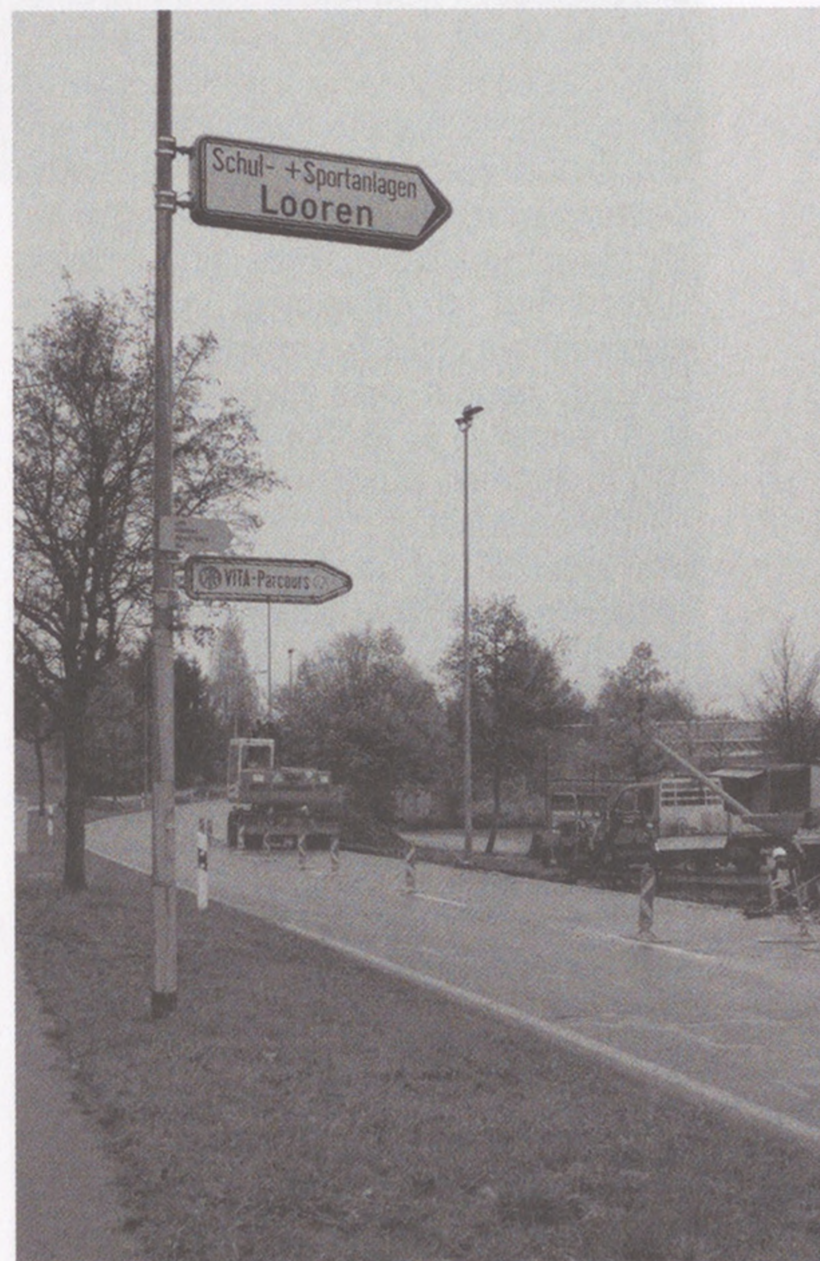
Am 14. Dezember hält erstmals der neue Bus an der neuen, provisorischen Bushaltestelle gegenüber der Schulanlage Looren. (Foto: sl)
