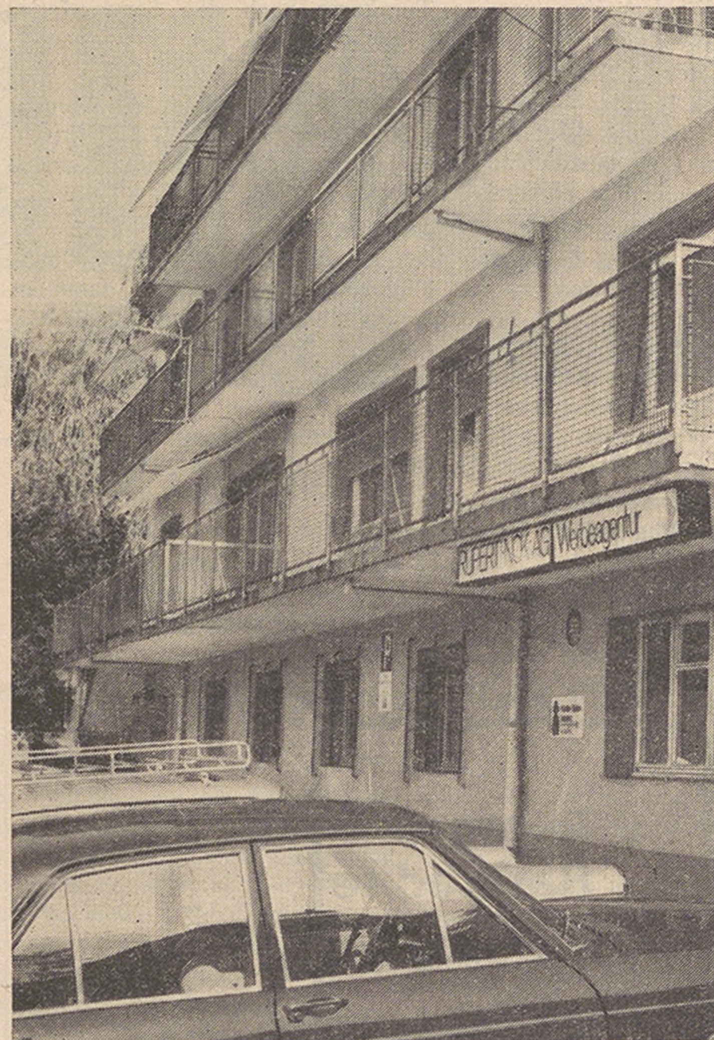
Vorhaldenstrasse 10, Werbeagentur Ruperti-NCK AG, wo früher das Hotel Europabrücke der Ruhe und Erholung diente, pulsiert heute das hektische Treiben eines dynamischen Werbeunternehmens.
