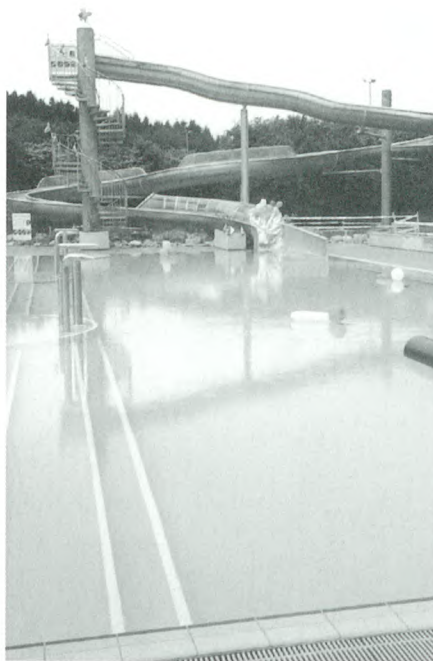
Das frisch sanierte Schwimmbad Eselriet.
