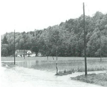
Zwischen Oberkempttal und der Neumühle.
