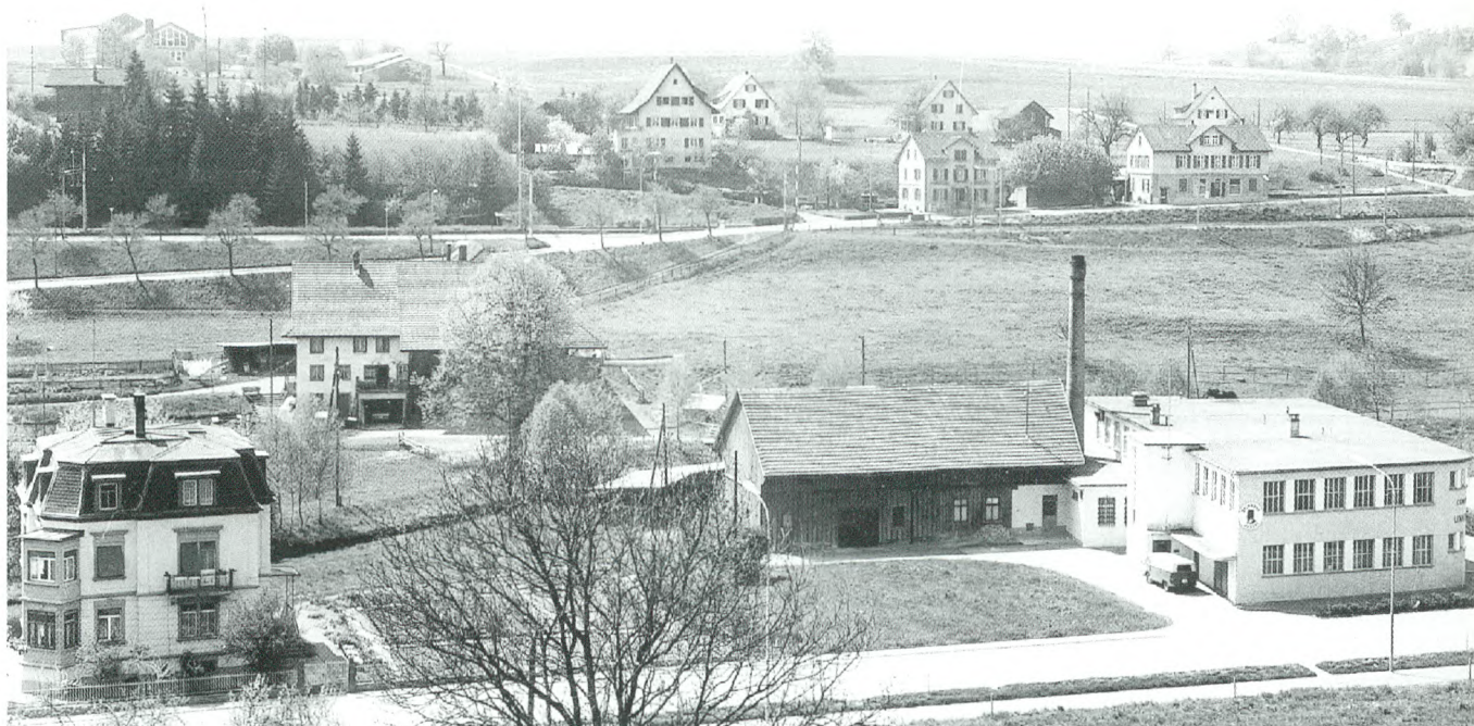
Die «Zätlifabrik» Union mit ihrem 22 Meter hohen Backsteinkamin war bis 1986 ein Bestandteil des Unter-Illnauer Dorfbildes.
