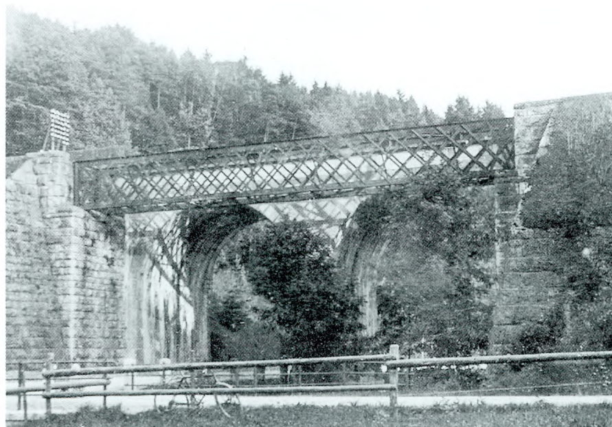
Der Mannenberger Viadukt um 1910. Vor der Steinbrücke der NOB ist die eiserne Brücke der Nationalbahn zu erkennen, die während des Ersten Weltkrieges abgebrochen wurde.
