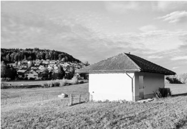
Frisch renoviert erstrahlt unser Pumpenhaus in neuem Glanz.
