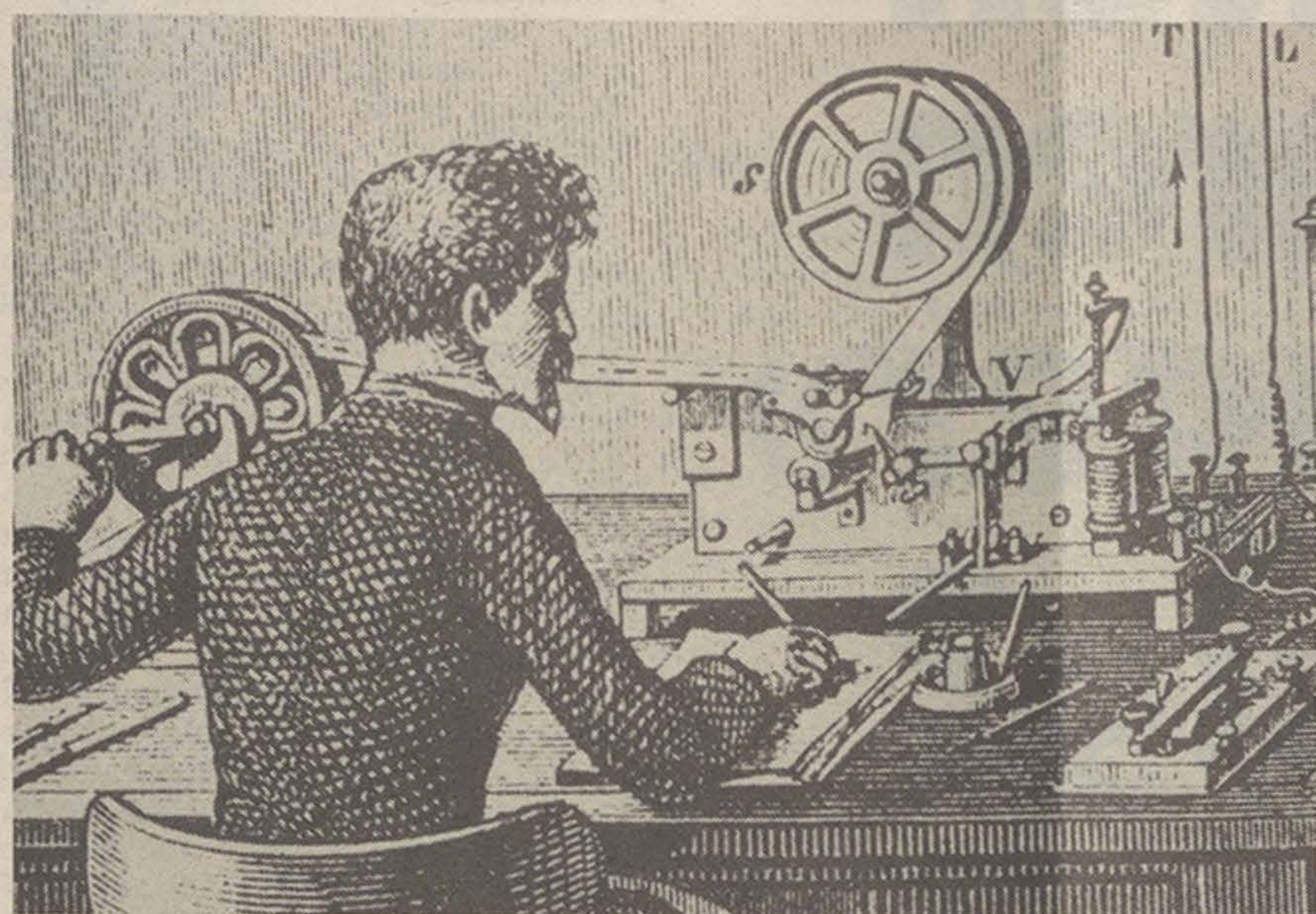
Orstelegrafist beim Decodieren eines ankommenden auf dem Papierstreifen sichtbar gemachten Morsecodes. Bei den von M. Hipp für die Eidg. Telegrafienwerkstätte konstruierten Telegrafienapparaten wird der Papierstreifen durch ein Gewicht mit regulierter Geschwindigkeit vorwärts gezogen.
