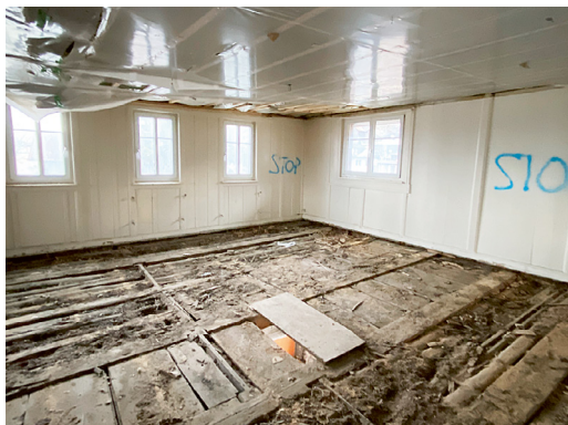
Gute Substanz: Architekt und Miteigentümer Cäsar Junker erklärt die Balkenlage im Dachstock vom «Wilden Mann», der noch im Originalzustand ist und nie für Wohnzwecke genutzt wurde. Nach dem Ausräumen sieht man in den unteren Etagen aber auch das Flickwerk, das durch Arbeiten am Objekt im Lauf der Jahre entstanden ist. Rechts unten: der freigelegte Fussboden im 1. Stock.
