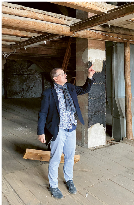
Gute Substanz: Architekt und Miteigentümer Cäsar Junker erklärt die Balkenlage im Dachstock vom «Wilden Mann», der noch im Originalzustand ist und nie für Wohnzwecke genutzt wurde. Nach dem Ausräumen sieht man in den unteren Etagen aber auch das Flickwerk, das durch Arbeiten am Objekt im Lauf der Jahre entstanden ist. Rechts unten: der freigelegte Fussboden im 1. Stock.
