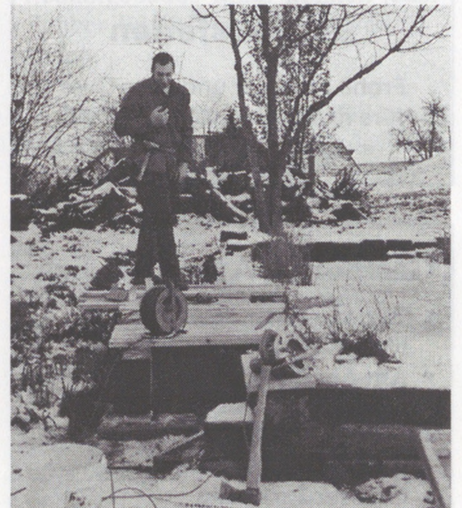
Biotopbrücke: Fertigstellung in Schnee und Eis durch Pascal Hüsey.
