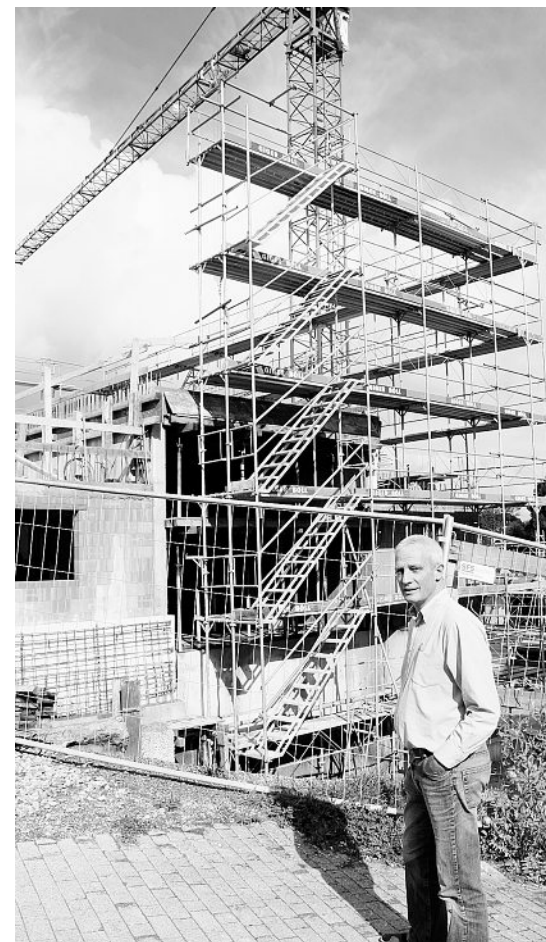
Architekt Peter Gröbly baut die Scheune um unter Beibehaltung der Form. (Foto: Elsbeth Stucky)
