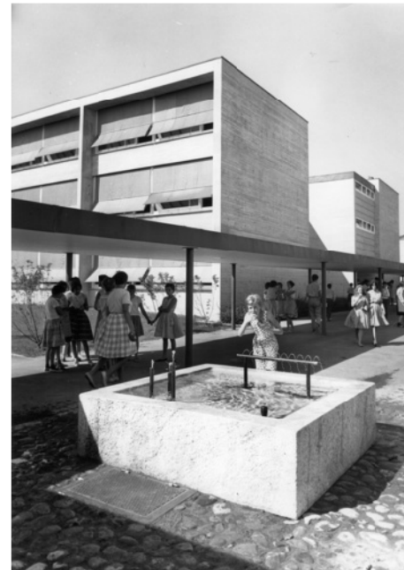
Die Schulanlage Buchlern kurz nach der Eröffnung 1959 (Bild: BAZ_158693, Welti)
