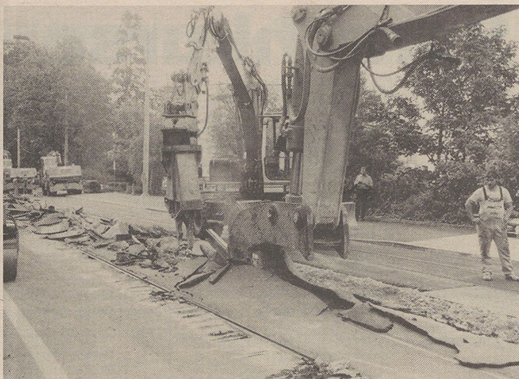
Riesige Maschinen reissen die Fahrspur auf; die alten Gleise knicken wie Streichhölzer.
