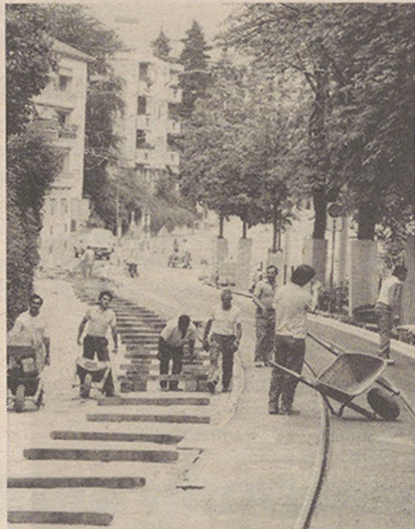
Die nächste Equipe bereitet die Linienführung der neuen Gleise vor.
