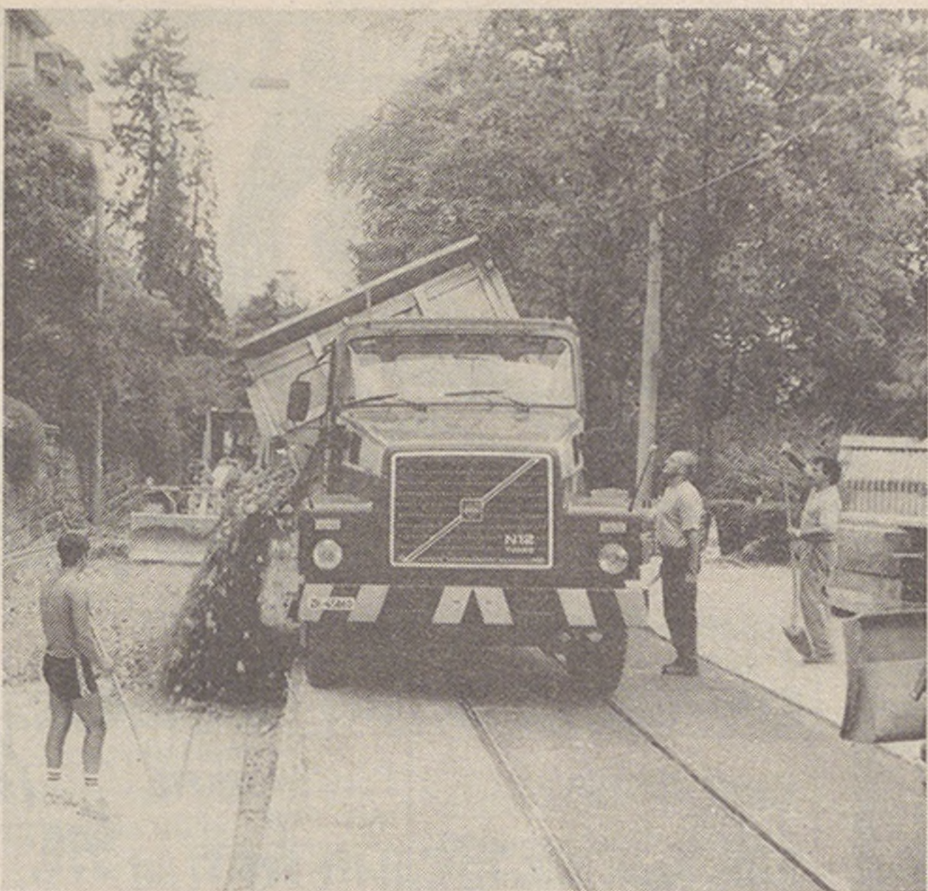
Aushub und Erstellen der Reinplanie erfordern genaueste Planung für die Lastwagenfahrer.
