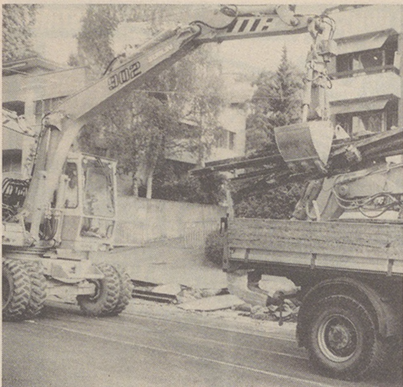
Abführen der alten Schienen.
