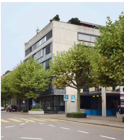
Das Hotel soll ab 2021 in barrierefreie Wohnungen umgenutzt werden – der Planungsprozess dafür ist angestossen
