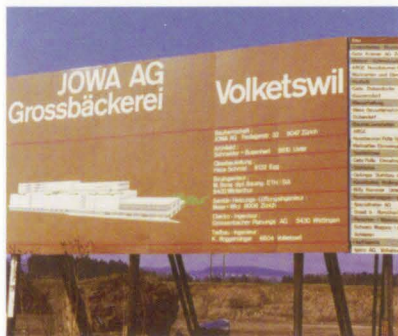
Das Projekt – viel Arbeit für viele Firmen (Foto: JOWA AG)
