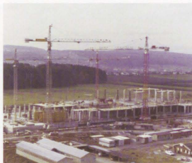
1977 - auf der grünen Wiese wird gebaut (Foto: JOWA AG)
