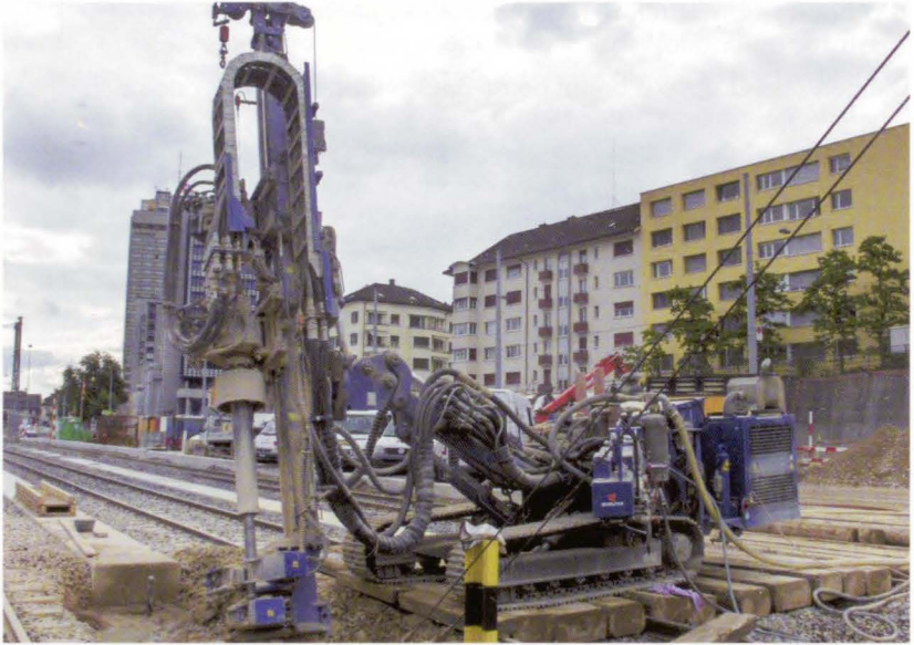
(Geotechnik) Bohrung von Mikropfählen im Bahnhof Oerlikon ZH 2010
