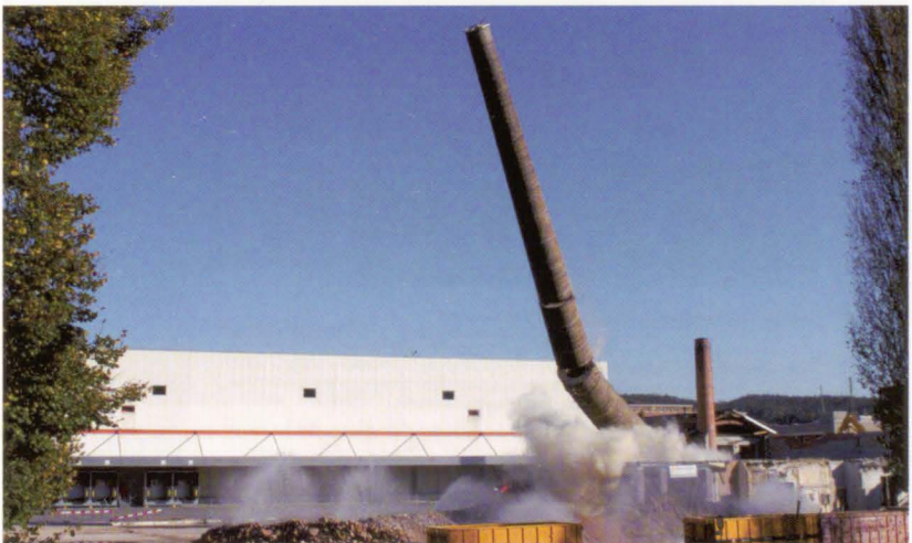
(Sprengtechnik) Kaminsprengung in Embrach 2008
