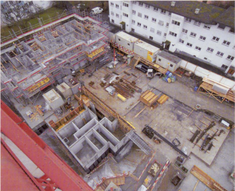
Moderne Baulogistik beim Neubau
