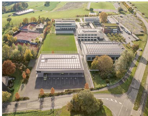
Loorenareal mit neuem Bevölkerungsschutzgebäude im Vordergrund.
