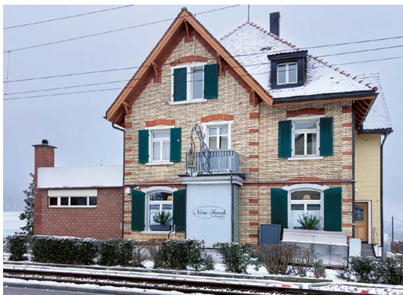
Topkulinarik mit Bahnanschluss: Die «Neue Forch» punktet.
