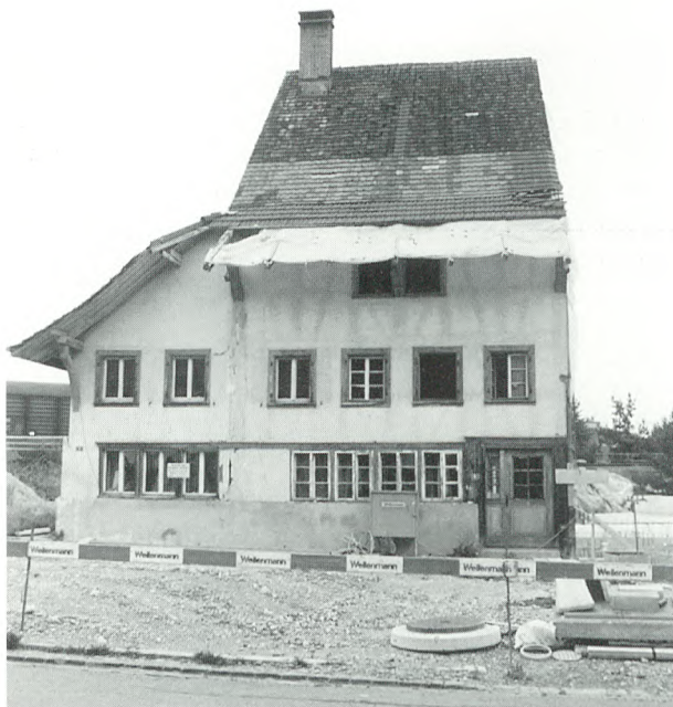
Das Bauernhaus aus dem 18. Jahrhundert wurde letztlich fast vollständig abgerissen (Kbz)
