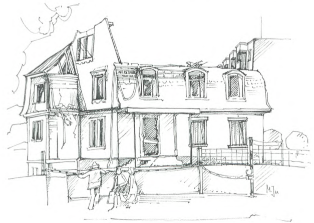
Abbruch des Widmer-Hauses im Frühjahr 1993
