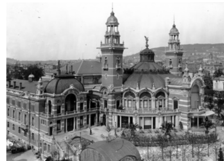
Abbruch 1937: Der alte Tonnalle-Pavillon (Foto: BAZ_054582, Ludwig Macher)
