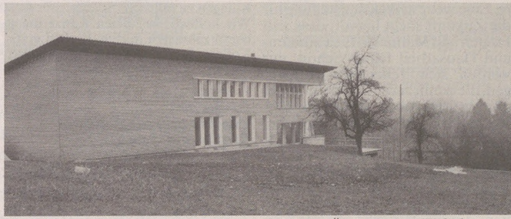
Westseite des Ökonomiegebäudes mit dem nahtlosen Übergang zum Wohnhaus.
