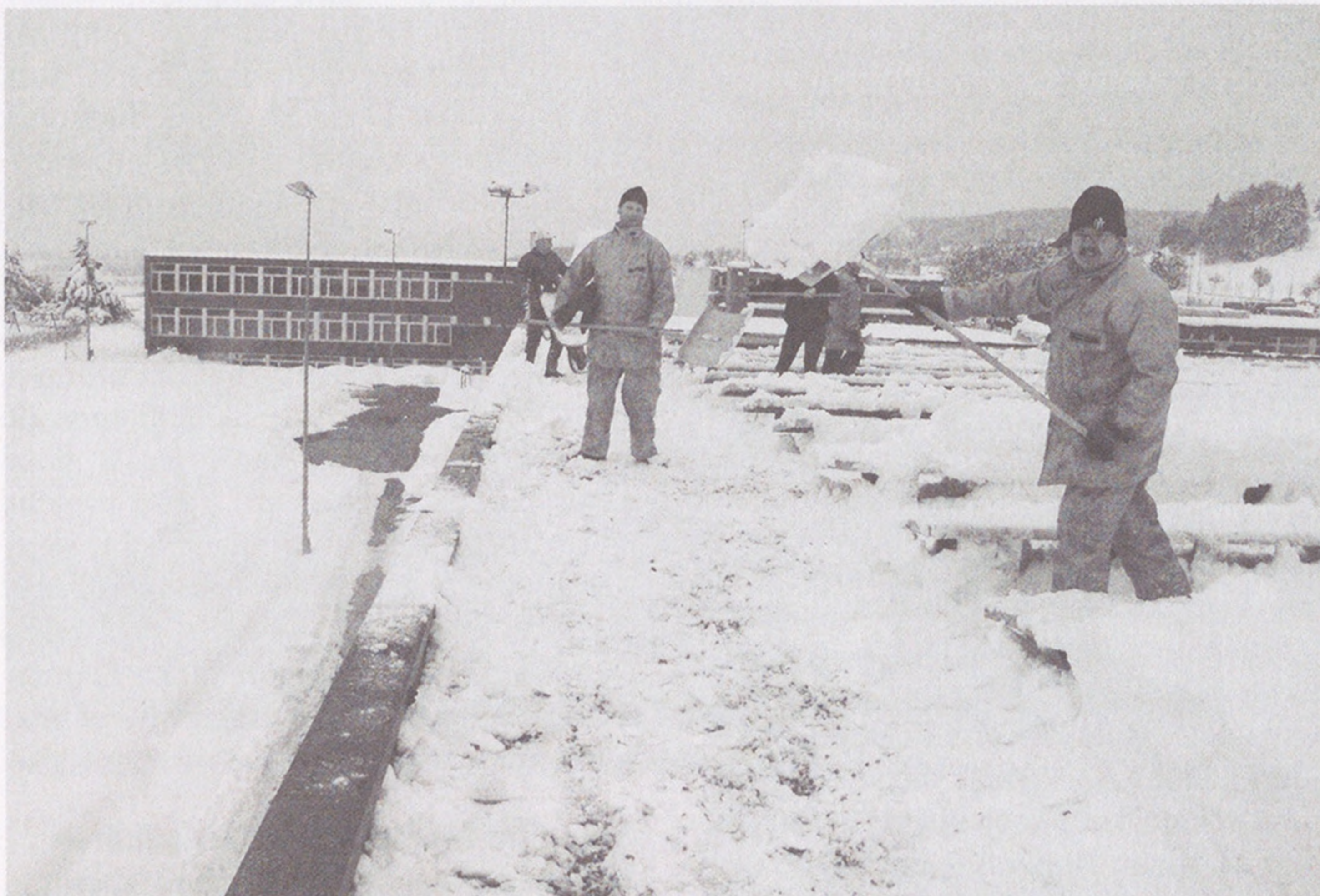
Sicherheitshalber wurde tonnenweise Schnee vom Dach der Dreifachturnhalle entfernt. (Foto: sl)
