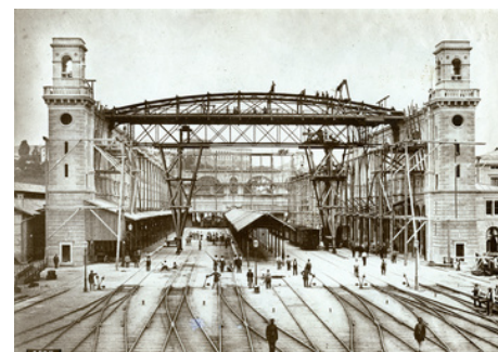
Der neue Hauptbahnhof im Bau 1867 (Foto: BAZ_098164)
