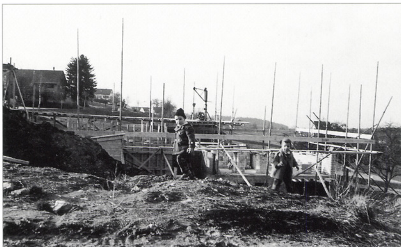
Die Baustelle des Doppel-einfamilienhauses Rohner und Brändli (1961), ein Paradies für die beiden älteren Brändli-Söhne.
