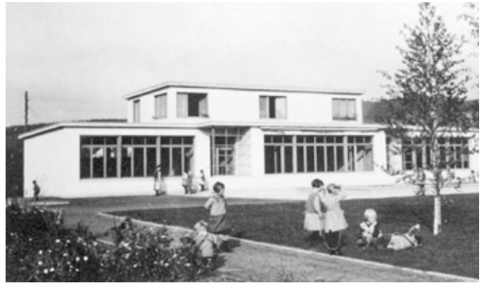
Im Kindergarten wurden vorübergehend Klassenräume eingerichtet.
