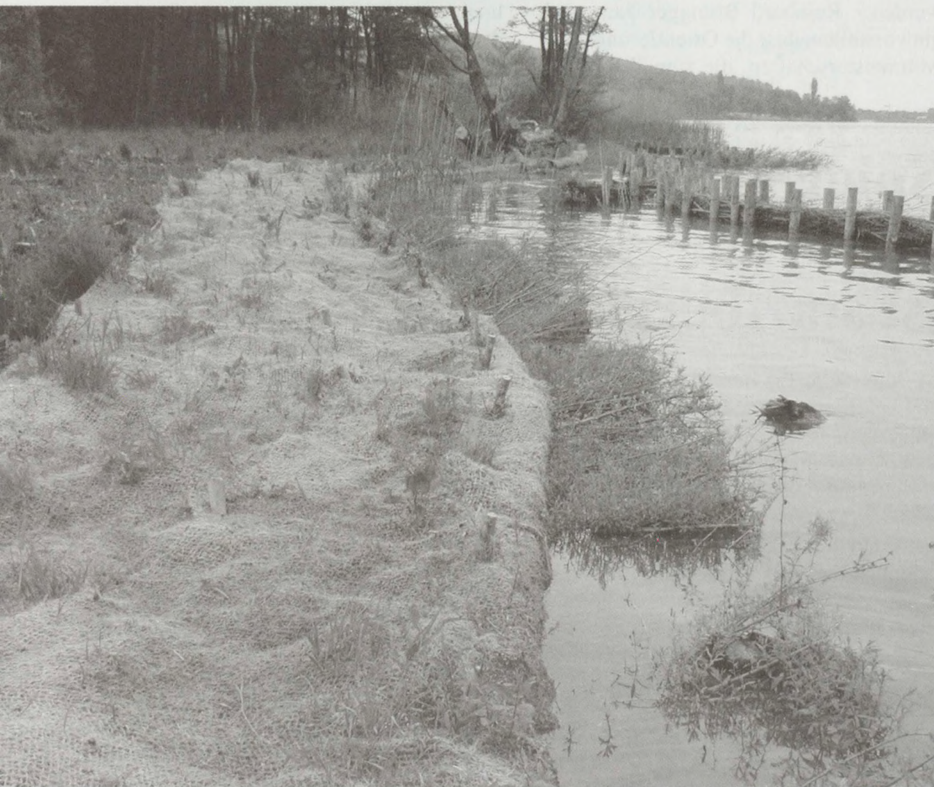
Erosionsschutzmatten im Bereich der neu stabilisierten Uferlinie im Projektgebiet Geren I. Die Aufnahme stammt vom Mai 2003. (Fotos: zvg)
