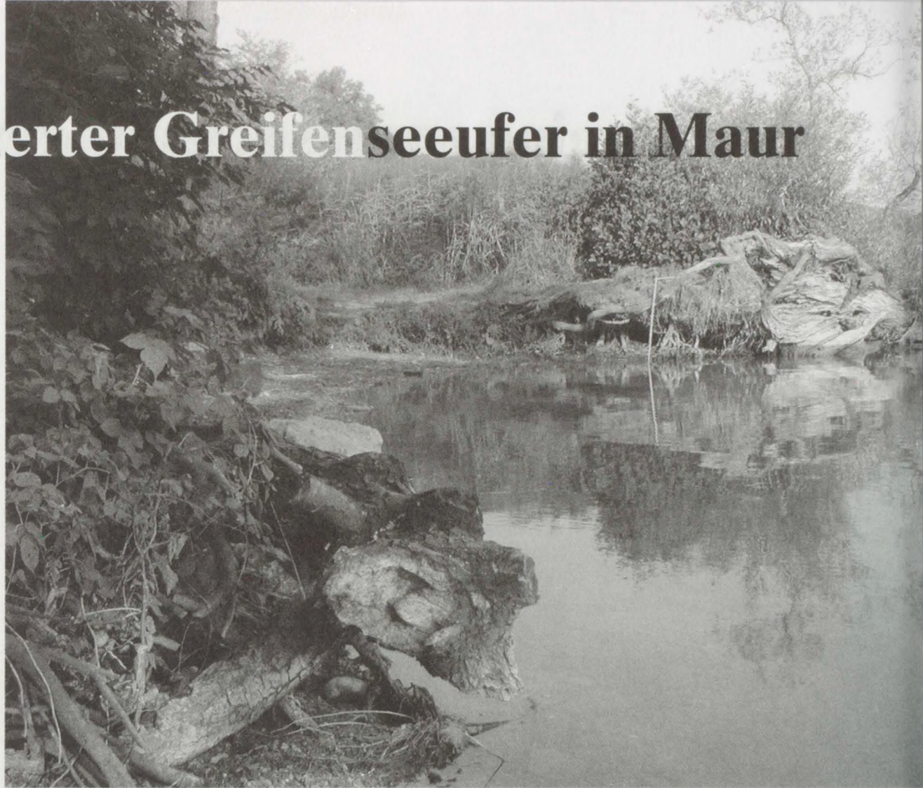
Schadstelle im Projektgebiet Geren II. Die Aufnahme stammt vom 9. August 2003.
