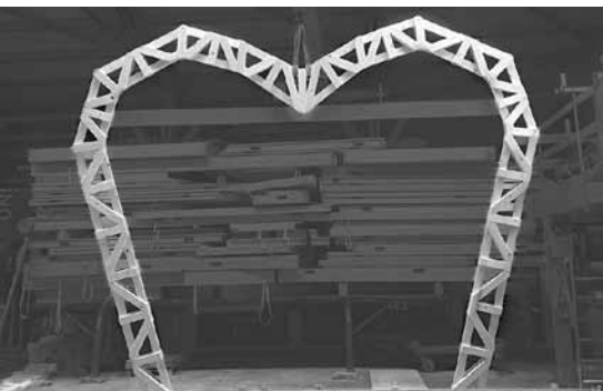
Torbogen im Bau: Aus Schweizer Fichten- und Tannenholz gefertigt.
