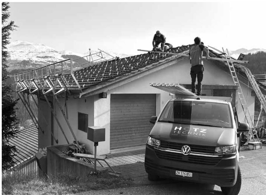
Montage unter alpinen Bedingungen: Schritt für Schritt werden Unterkonstruktionen und Kabelzüge installiert.
